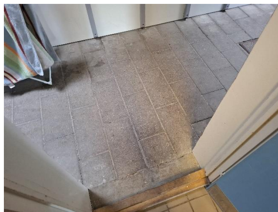
Betonfliser i fordelingsgang
