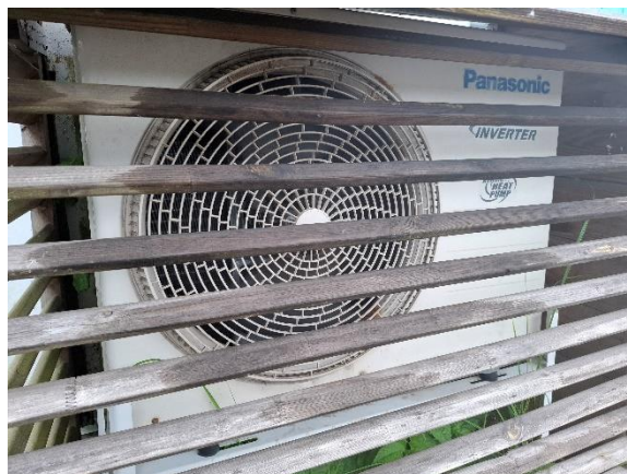
Varmepumpe, udvendig del
