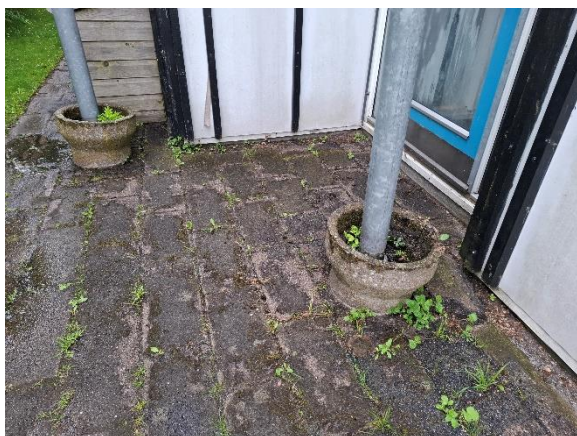
Nedløbsbrønde mod nord
