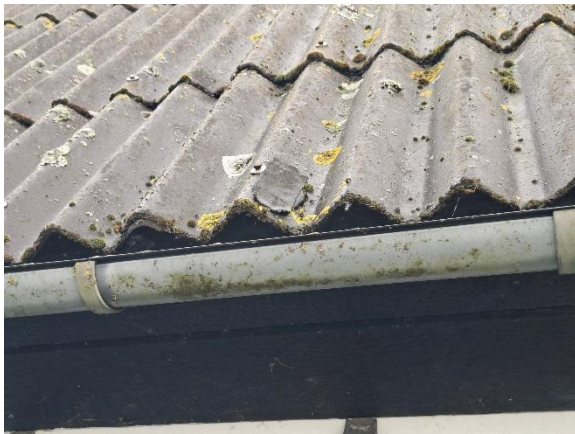
Der ses enkelte lapninger og udskiftninger af plader
