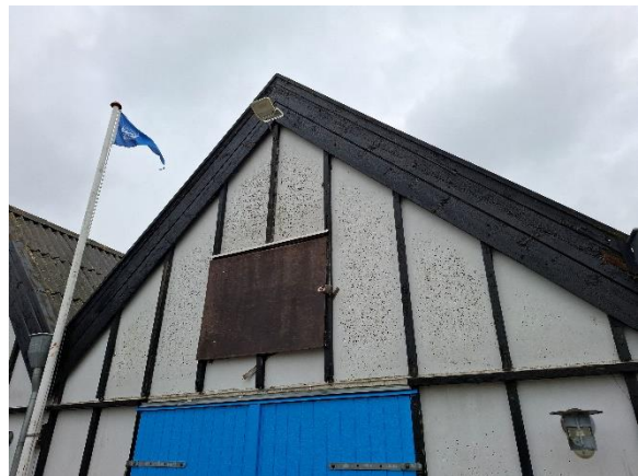
Algebegroninger på fibercementplader.
