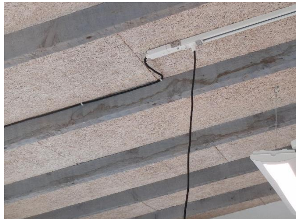
Lofter med lægter og træbeton i kajakklubbens fælleslokale. Der er skjolder på lægter
