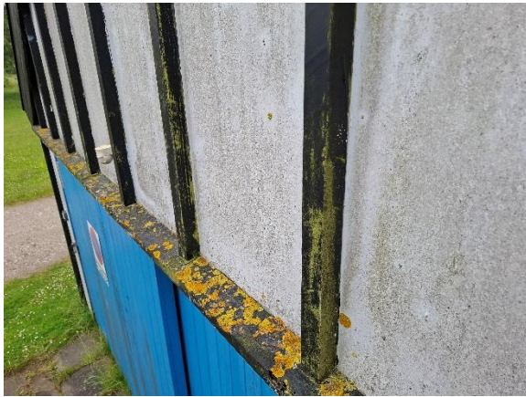
Algebegroninger på lister og fibercementplader
