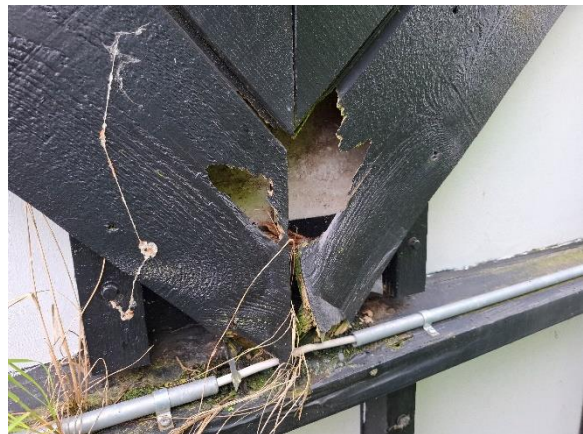
Vindskeder er rådnet helt væk mod nord under skotrende.
