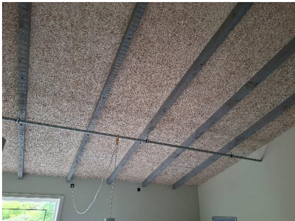
Lofter i fælleslokale med træbeton og lægter
