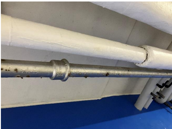
Gennemtæringler flere steder på faldstamme.
