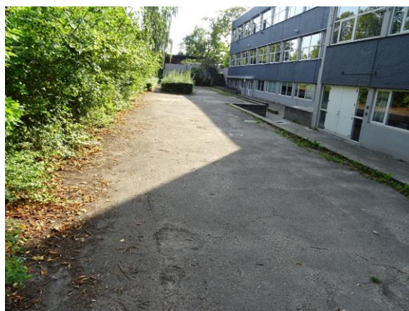
Asfalt Ved Lindelunden
