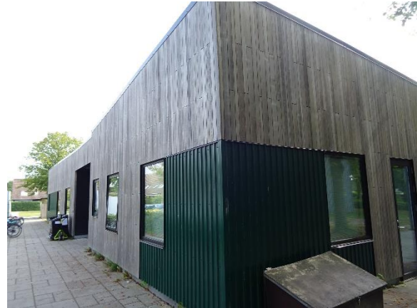
Vinduer med 3-lags energiruder i Ventilen
