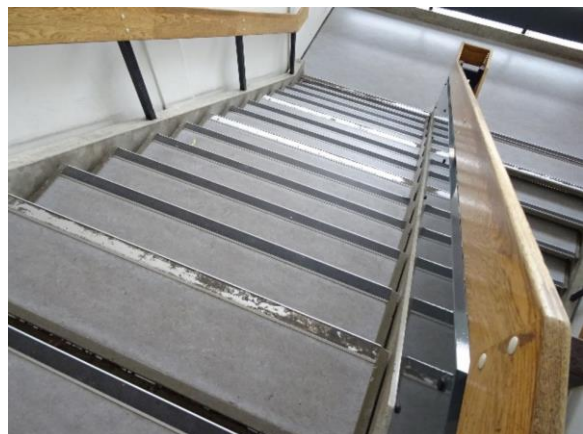
Trappe fra 1. sal, trinfor kanter er slidt
