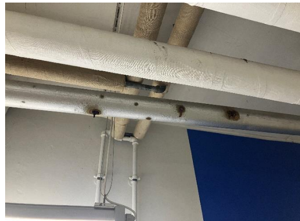
Store udfældninger på flader fra mikro revner.
