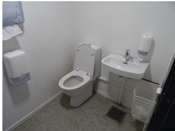
Nyere toilet og vask
