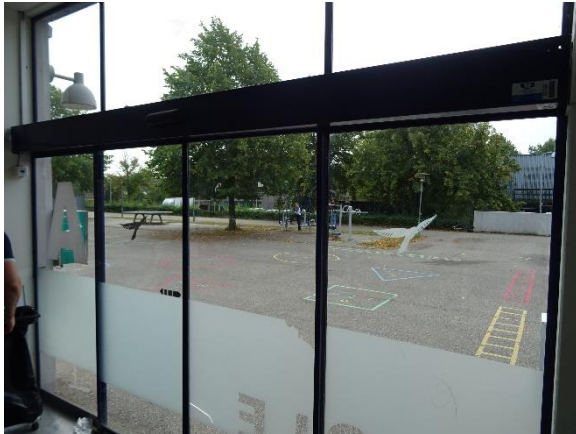
Skydedøre, hovedindgang A og B med et lag glas
