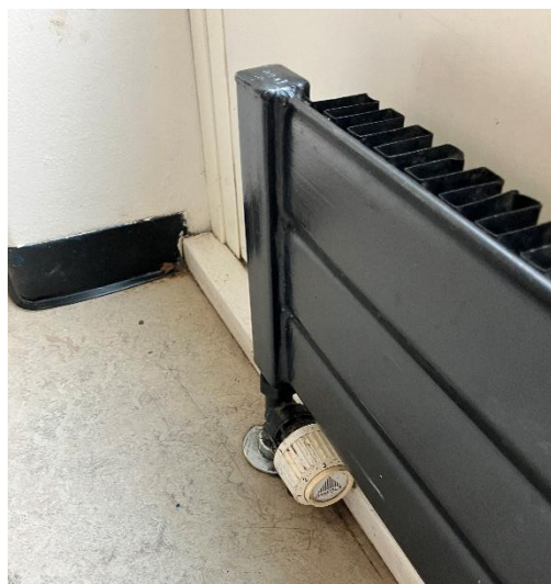
Termostatventil fra perioden 1994-2003
