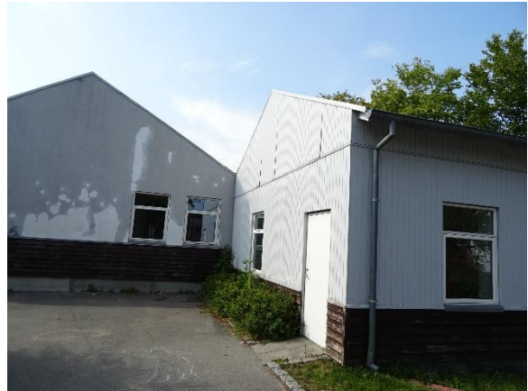
Pudsreparationer på facade og profileret krydsfiner på gavle gaber
