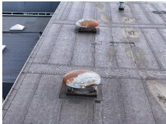
Derbigum på 1. sal og udsugningsventilatorer
