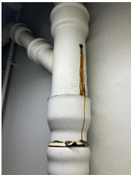
Mikrorevner og udposende mængering.
