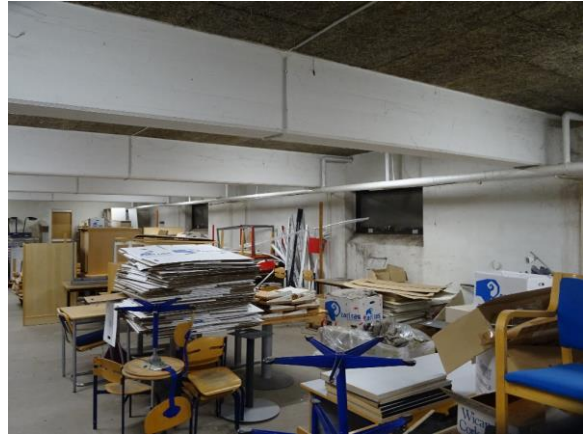
Depot i kælder
