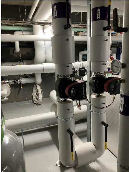
Hovedfordelingspumper, redundante
