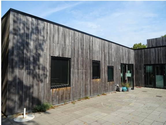
Vinduer i Ventilen fra 2023
