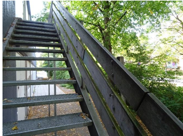
Udvendig sikkerhedstrappe i stål
