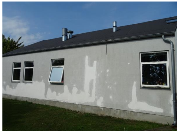
Facadepuds på net og isolering
