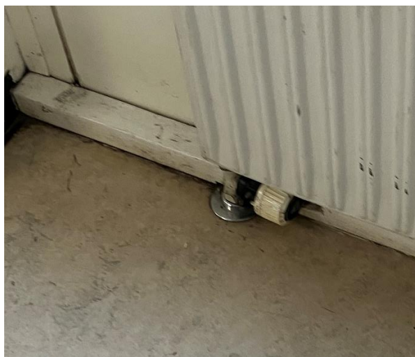
Termostatventil fra perioden 1985-1994
