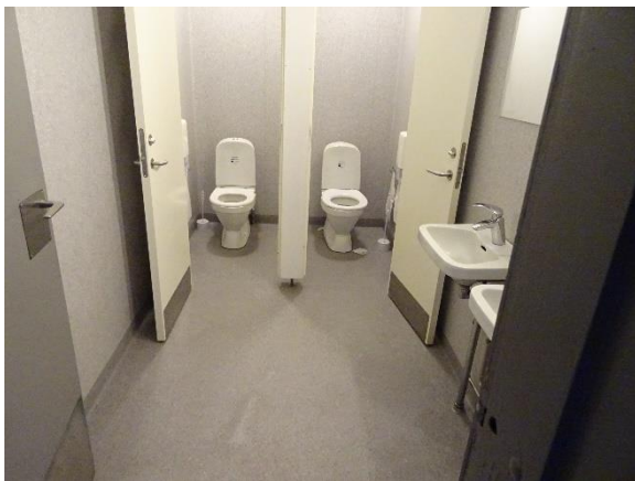
Ældre toilet i stueetagen
