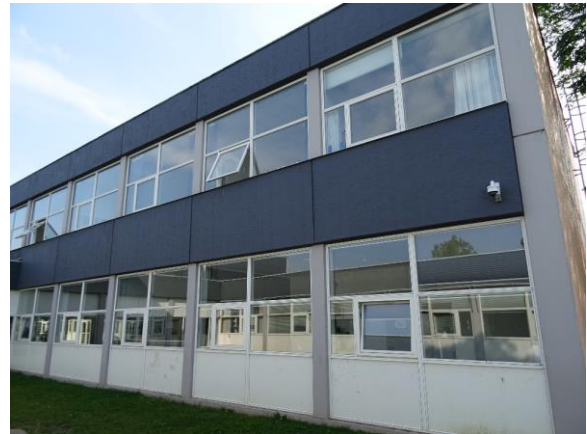
Facade, betonelementer er malede
