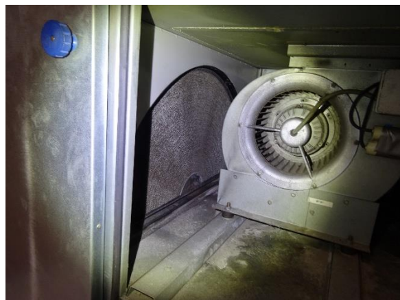
Rengøring af rotorveksler tilrådes
