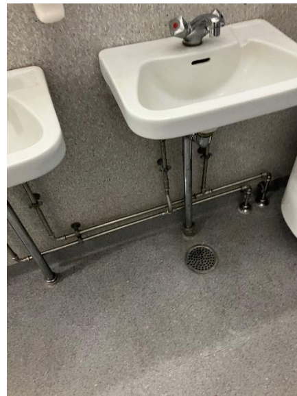
Presfit på installationsrørene
