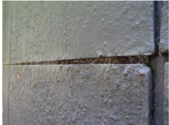
Vandret fuge mellem betonelementer
