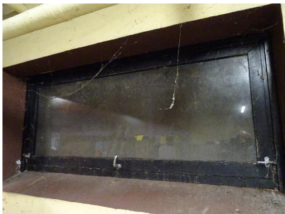
Oprindeligt vindue i sikringsrum kælder, 1 lag glas
