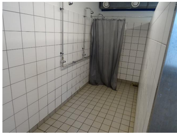
Brusere med selvluukkende bruseventil og forblende vand
