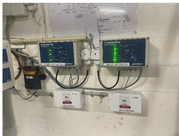
Læksikrings automatik
