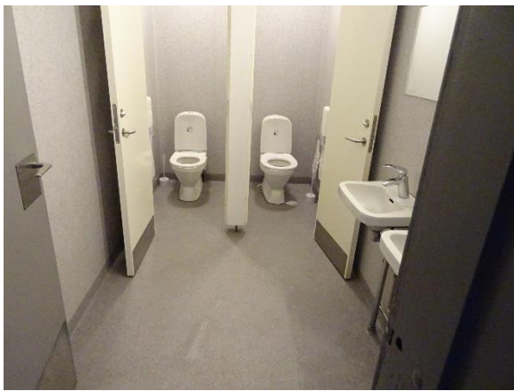
Ældre toilet i stueetagen
