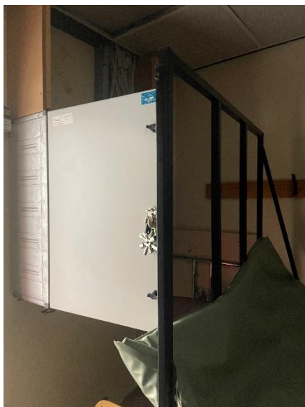
Eksempel på tavle hvor respekt afstand ikke overholdes
