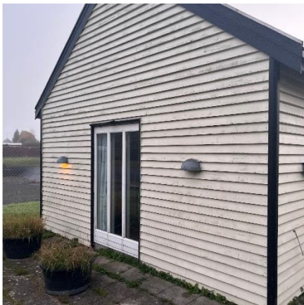
B1 Vinduesparti i gavl
