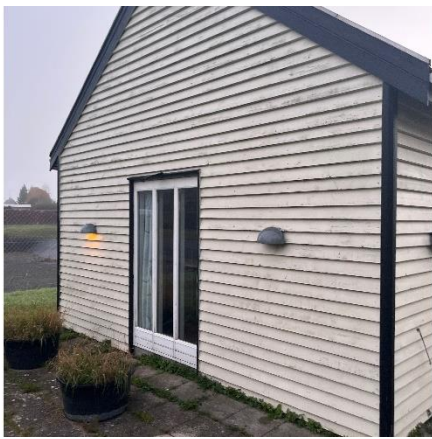
B1 Vinduesparti i gavl
