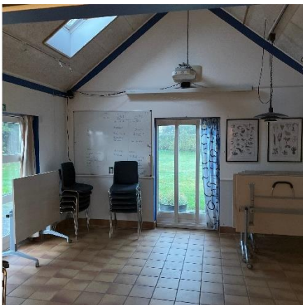
B1 Klinkegulv i undervisningsrum
