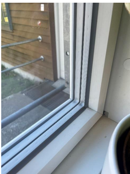
tre lags energirude med koldkant i alu ramme fra 2009
