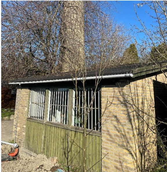
Udhus med skorsten (BBR bygning 4)
