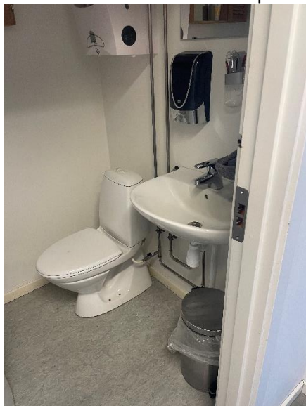
Toilet for personale aflåst fra bygningens øvrige brugere.
