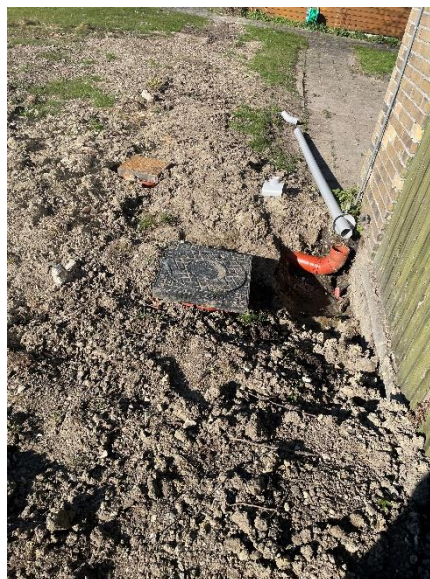
Del af kloak ved JAC bygning som der arbejdes på
