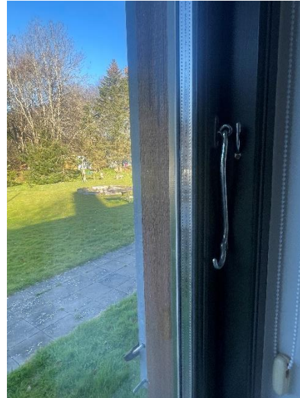
To lags energirude med kold kant
