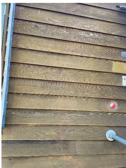
Udsnit af klinkbeklædt træfacade af
