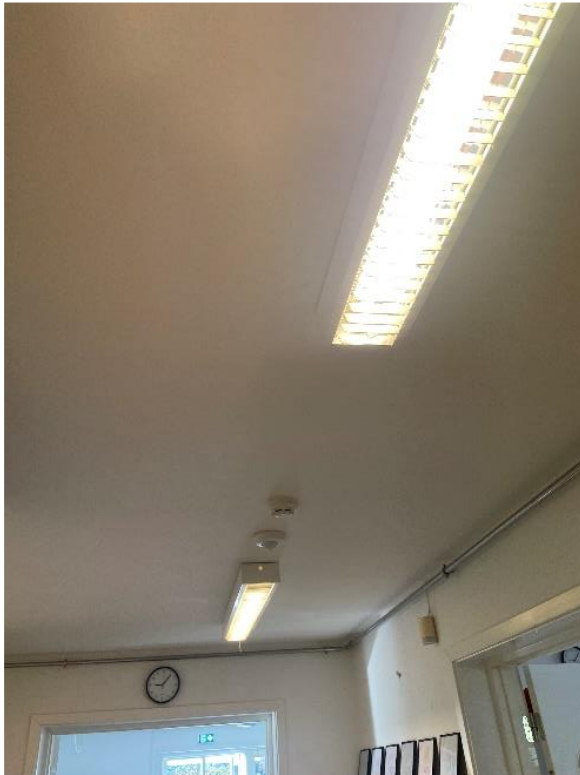
Den primære belysning er af lysstof 36W med sensor
