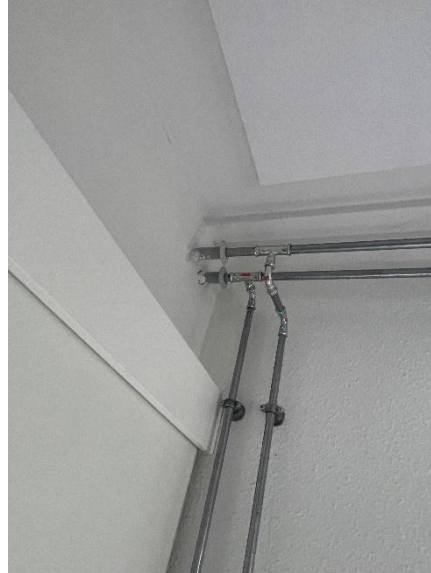
Vandrør i den opvarmet zone
