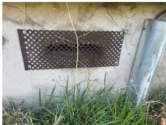
Ventilationsrist i sokkel på hovedbygning
