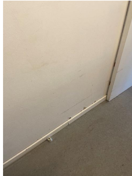
Gipsvæg med slidmærker og revner i samlinger
