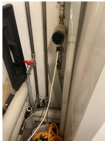
De isolerede rør i bunden er fjernvarmerør.
