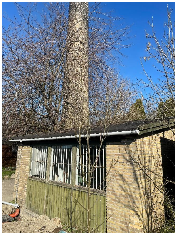
Udhus med skorsten (BBR bygning 4)
