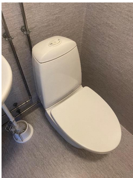
Toilet med vinylgulv og væg
