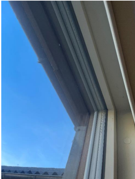
Tre lags energirude med kold kant
