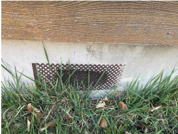
Fundament med ventilations skakt.
