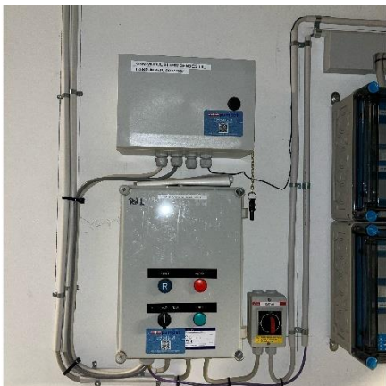
GSM-Modul og pumpestyring
