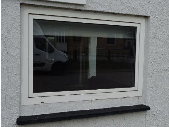
Vindue mod øst
