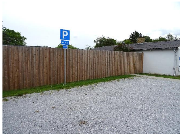
Parkeringsplads med nyt plankeværk
