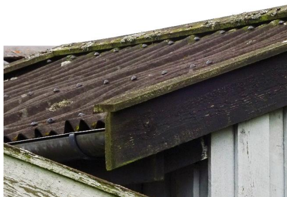
Tagbelægning på skur til spånsug
