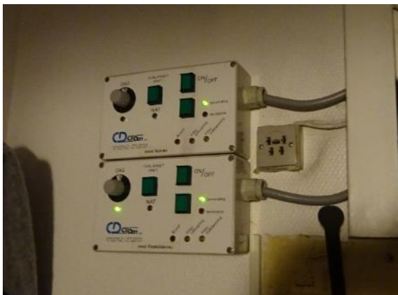
Styring til ventilation
