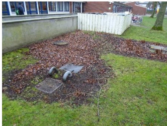
Vand og afløb øst for bygning
