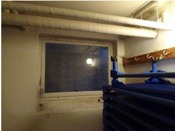
Et lags vindue i kælder
