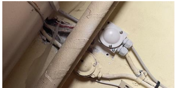
Ubrugte lampeudtag i pudsle/toilet rum, FARE for Elektrisk stød.
