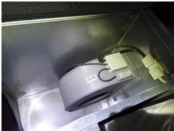
Indblæsningsventilator
