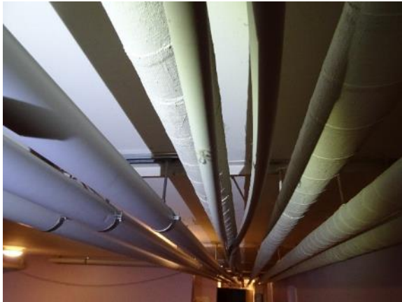
Vand og varmeinstallation i kælder
