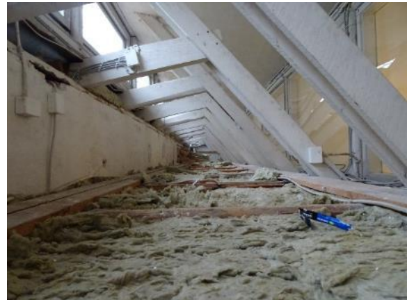
Mod uudnyttet loftsrums, 100 mm mellem spær
