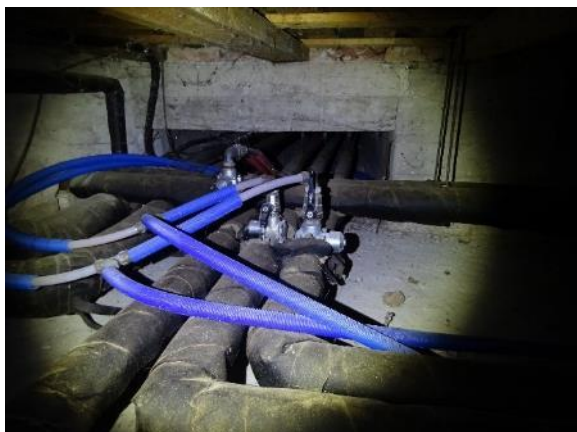
Varmerør og brugsvandsrør i krybekælder
