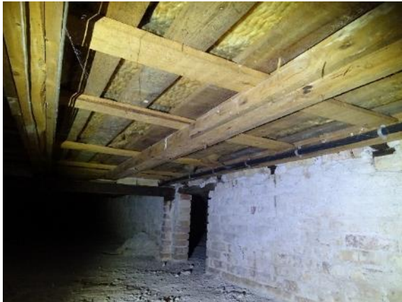
Underside af krybekælderdek
