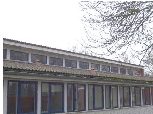
Østvendt tagflade på den nordligste bygning, hætter i pvc
