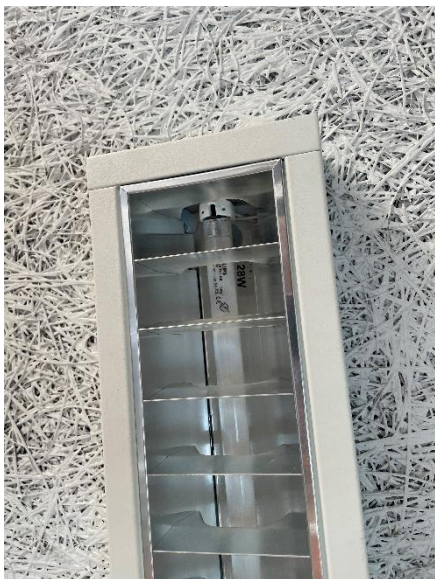
Spolerørs armatur i gang
