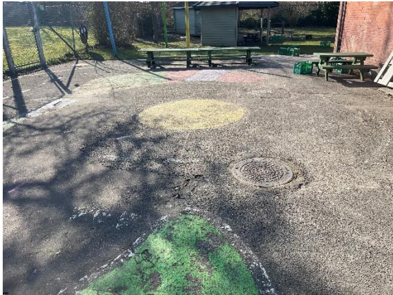
Asfalt øst for bygning
