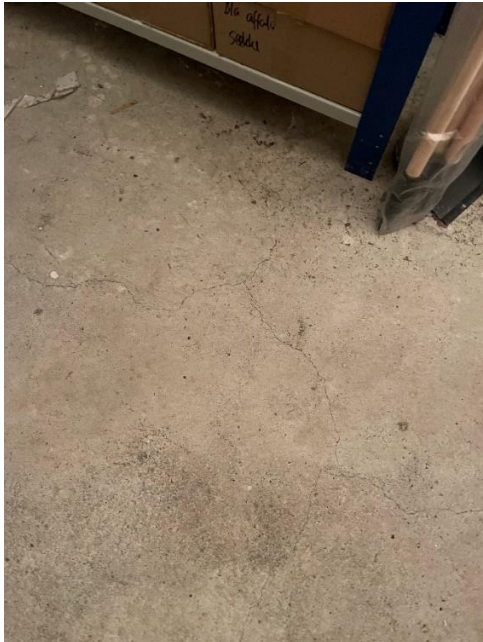
Betondæk i kælder
