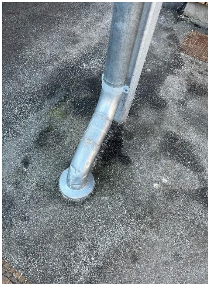
Udsat nedløbsrør til ny tilbygning
