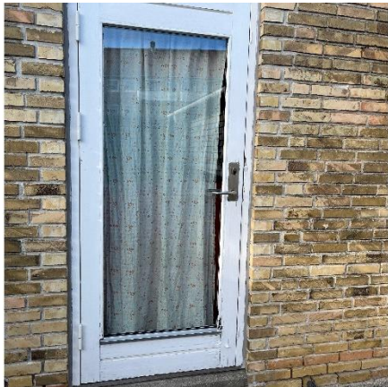
Dør i gavl mod sydøst
