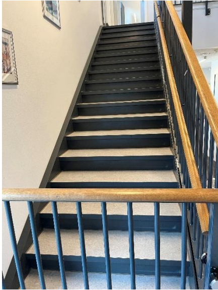
Indvendig trappe i ny tilbygning
