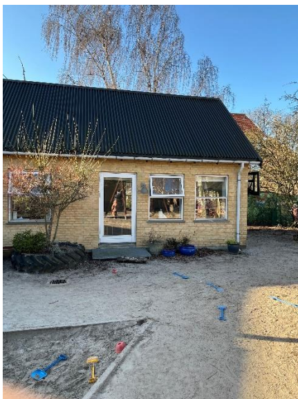
Vinduesfacade i tilbygning mod vest
