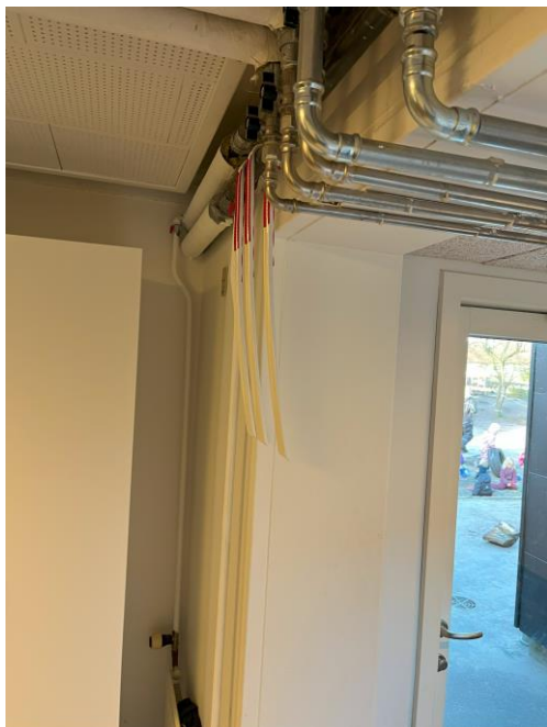
Varmerør til ny tilbygning.
