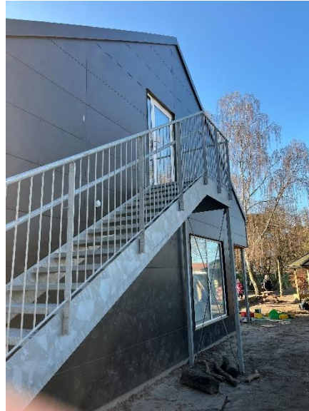
Udvendig trappe i ny tilbygning
