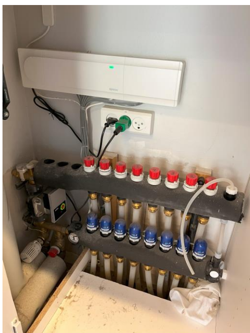
Gulvvarmehunt til ny tilbygning
