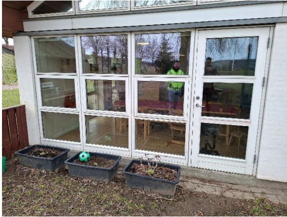
Vinduespartier mod syd
