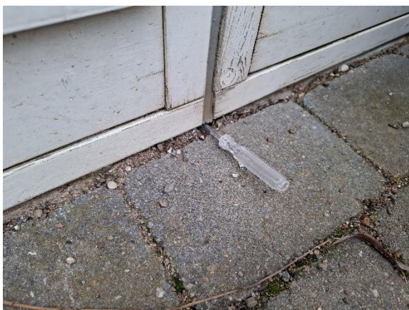
Fuge er væk grundet placering i terrænhøjde.
