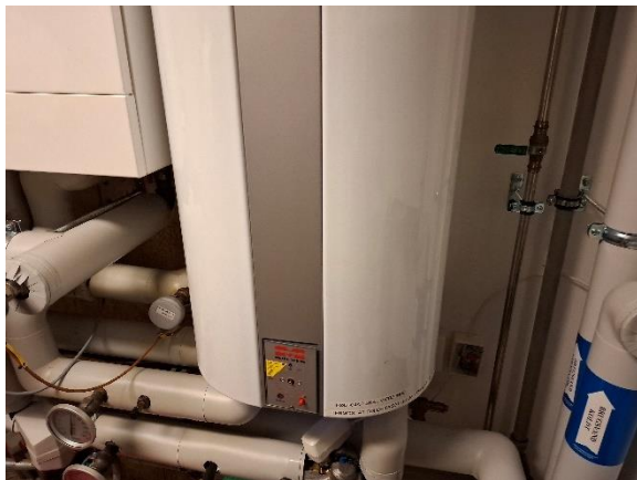
Varmtvandsbeholder
