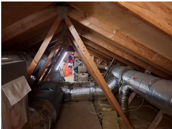
Kanaler i loftrum
