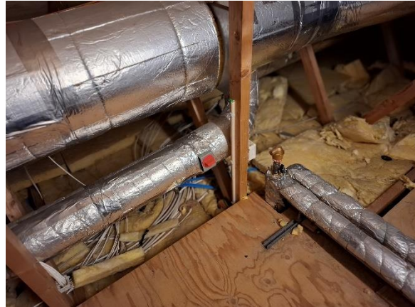
Kanaler i loftrum
