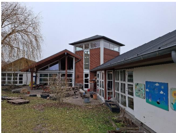
Vinduespartier mod syd
