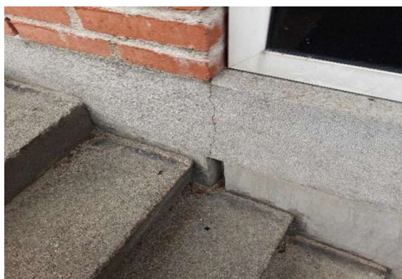
C: Kældervæg ved kældertrappe, bygning 12
