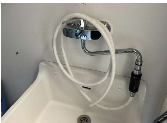
Armatør over rengøringsvask, 1-grebs, skjulte vandrør
