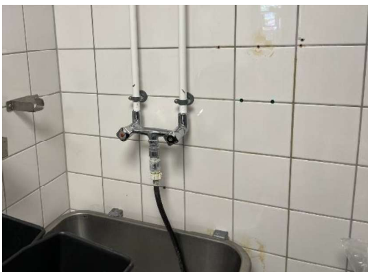
Armatür over rengøringsvask 2 grebs
