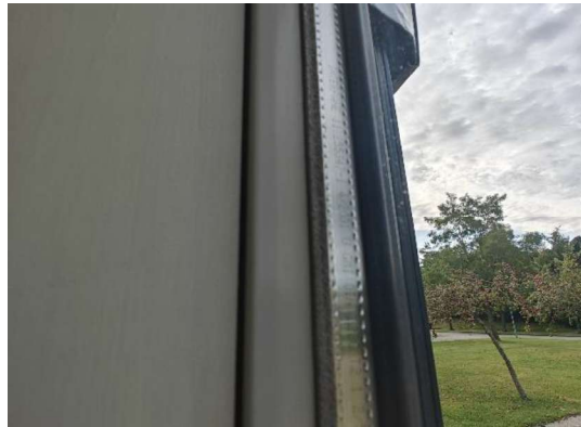
Vindue i administrationsbygning
