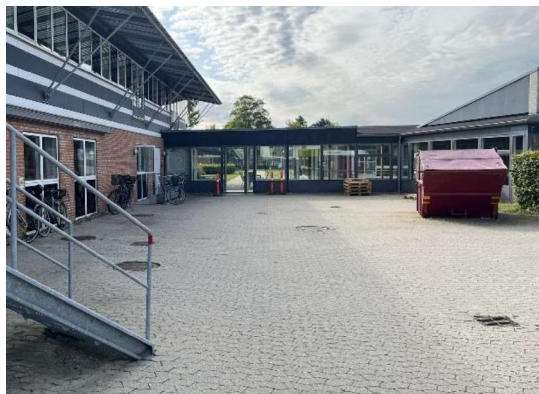
Nedløbsriste og dæksler i flisebelægning
