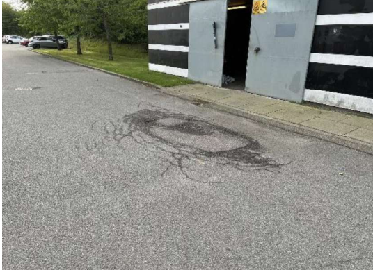
Port på maskinhus
