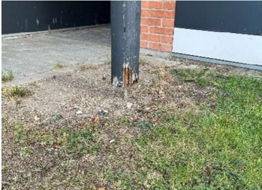
Træsøjle ved udhæng
