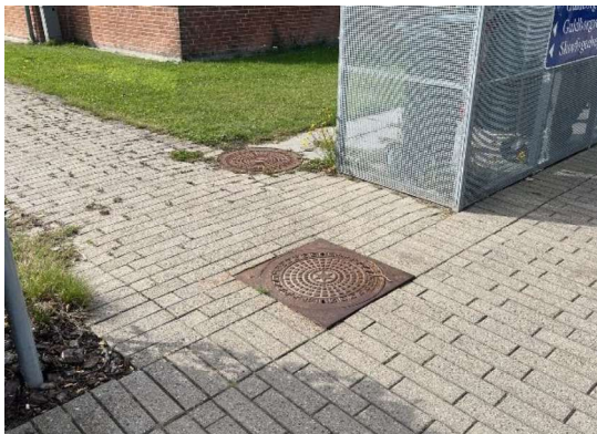
Brønde og kloakdæksler i terræn.
