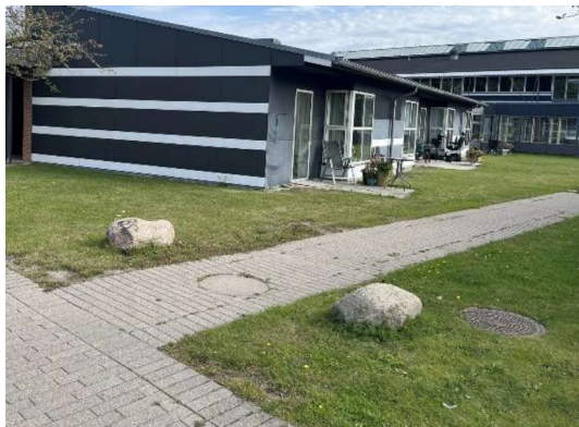
Brønde og kloakdæksler i terræn.
