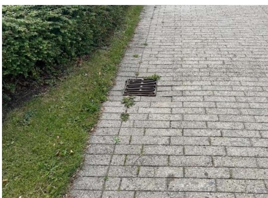
Nedløbsrist i flisebelægning.
