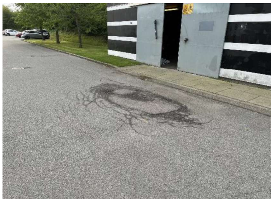
Asfaltbelægning foran maskinhus
