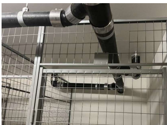
Afløbsinstallation støbejernsrør under loft i kælder, i en enkelt af bygningerne.
