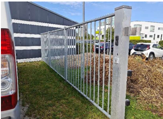
Port på østlig side
