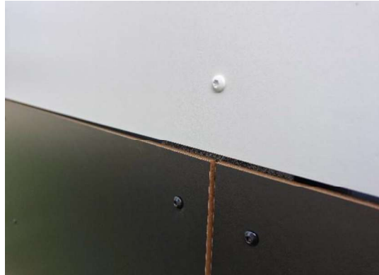
Nye facadeplader opsat på gavl
