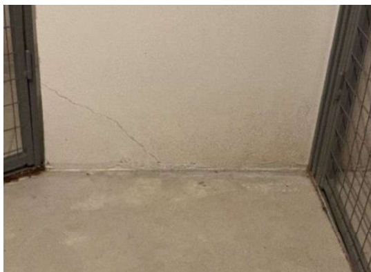
E: Kælderydervæg, bygning 12
