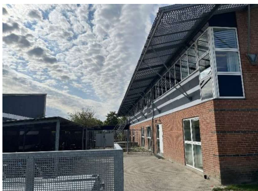
Vinduer på øst facade
