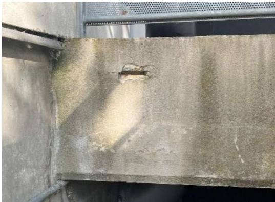
A: Dæk over kældertrappe, bygning 12
