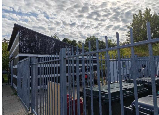
Port til materiel gård i tilknytning til maskinhus
