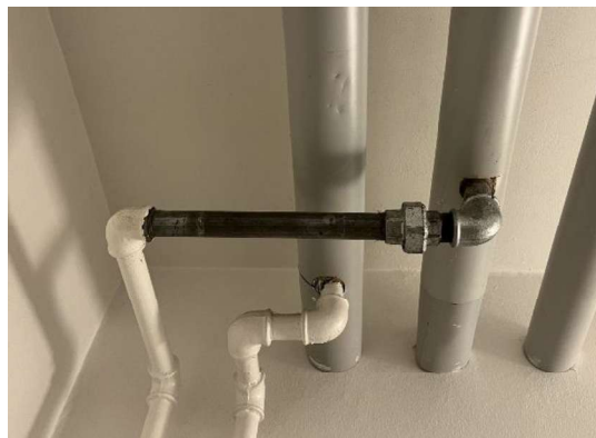
Vandrør under loft kælder, punktvís udskiftning
