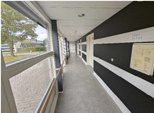
Vindue i administrationsbygning
