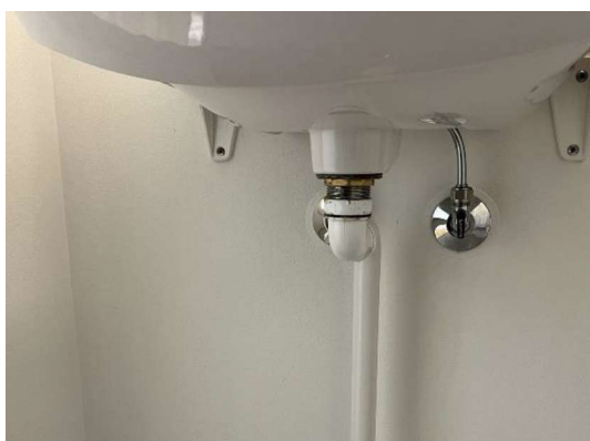
Tilslutning for armatur under håndvask, skjulte vandrør
