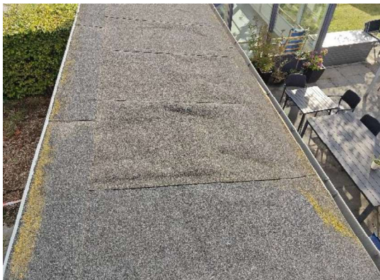
Dampbuler på mellembygning set fra bygning 6 mod bygning 8.
