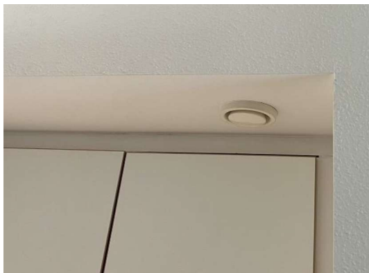
Armatur for udsugning i køkken
