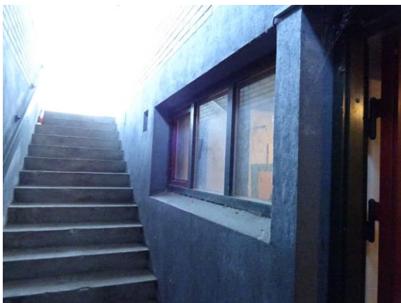
Kælderhals- og trappe i beton
