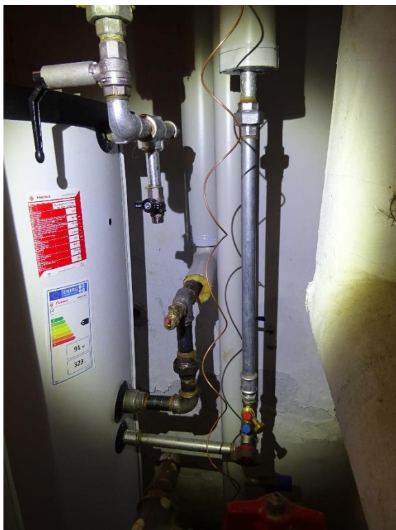
Brugsvandsrør isoleret
