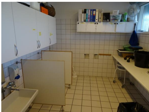
Toilet nordbygning m. lugtgener
