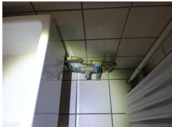
Overgang til installation i badeværelse i kobber
