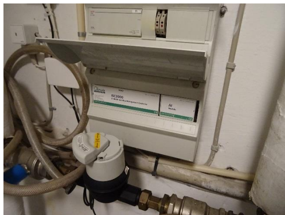
Clorius varme og vent. styring
