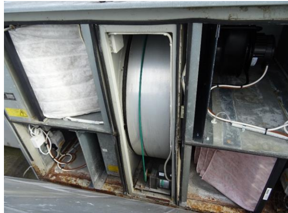
Ventilatorer og rotorveksler er skiftet
