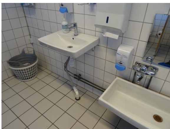
Renoveret toilet midterbygning
