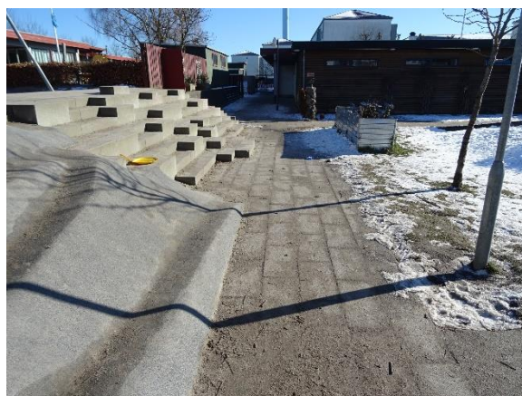
Flisebelægning på legeplads
