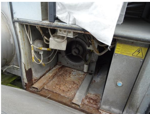
Midterbygning, gamle ventilatorer og elvarmeblade
