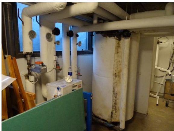
Vandskadedet beholder
