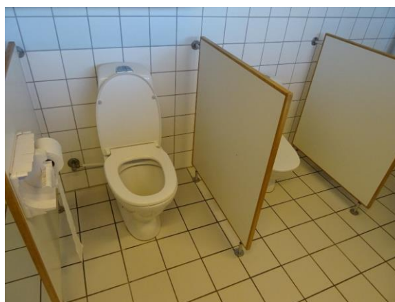
Renoveret toilet midterbygning
