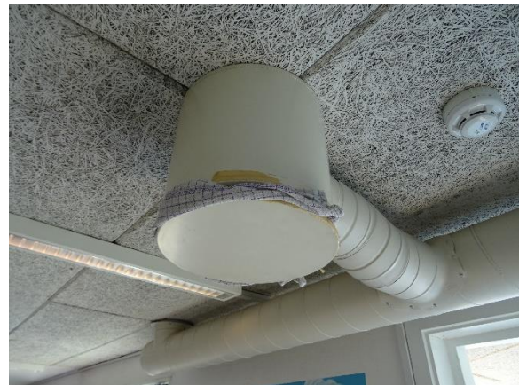
Armaturer tilstoppet med viskestykker
