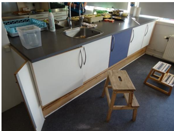
Køkken midterste bygning
