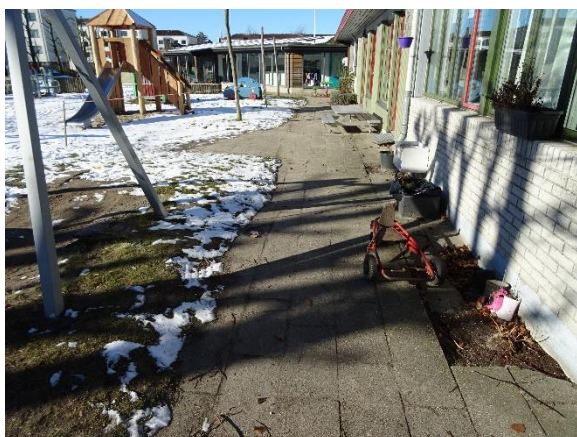
Flisebelægning på legeplads
