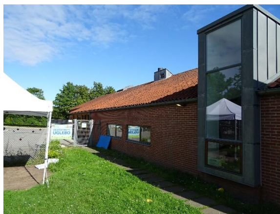
Flisebelægning nord om bygning
