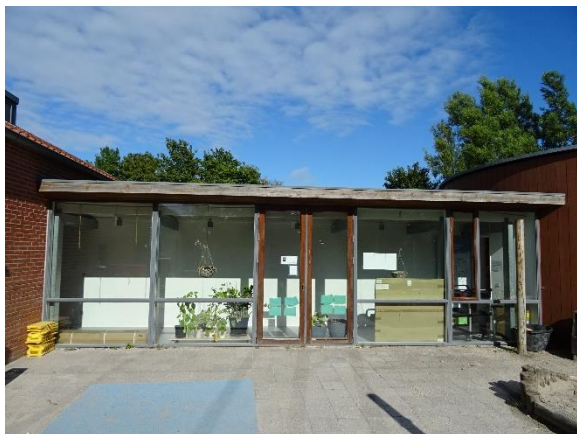
Vinduer i forbindelsesgang
