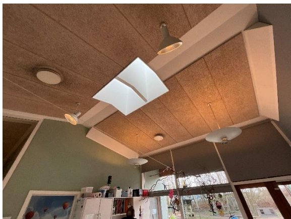
Loft træbeton og lysskakt/rytterlys
