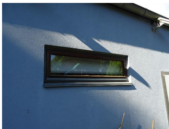
Vindue i sydfacade
