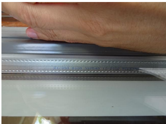
Rude hovedbygning dateret 10/2002
