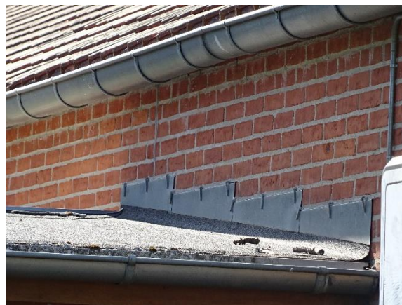
Tagpaptag, overgang hovedbygning til forbindelsesgang
