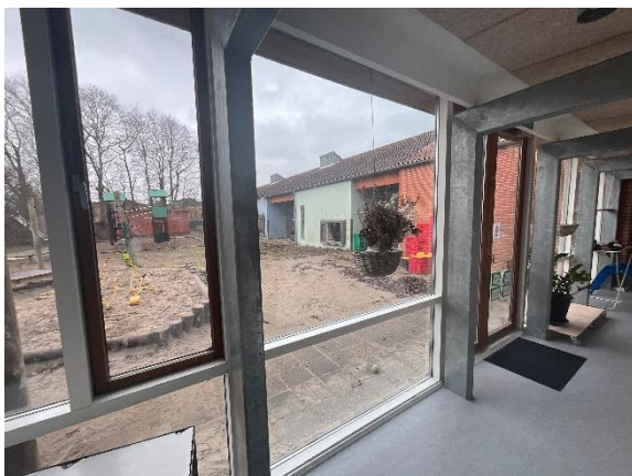
Faste vinduespartier i gang
