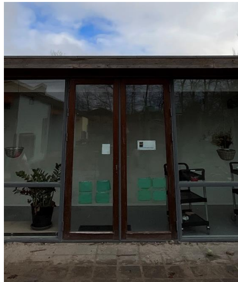
Dør i forbindelsesgang
