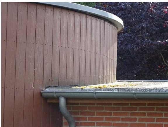
Tønnebygning, skruer og tilskæring mod tagflade
