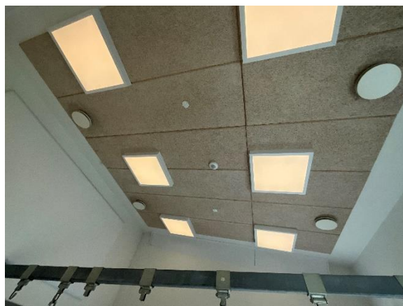
Loft i træbeton
