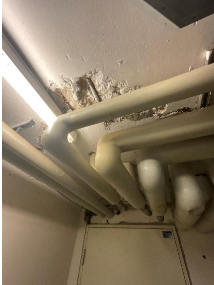
Synligt armering i kælder loft
