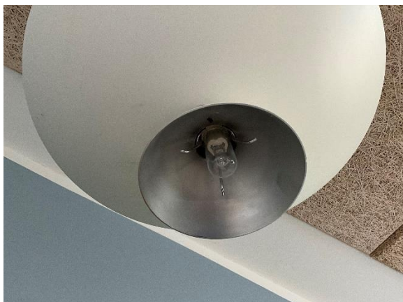
Up/downlight pendler med halogenpærer
