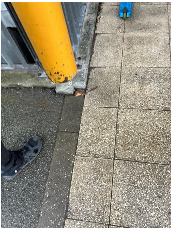
Søjle med mindre afskalning fra bunden
