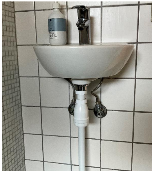
Fast rør i plast med pung vandlås.
