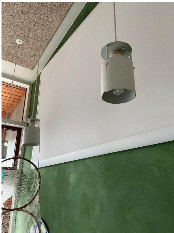
Pendler med kompaktrør
