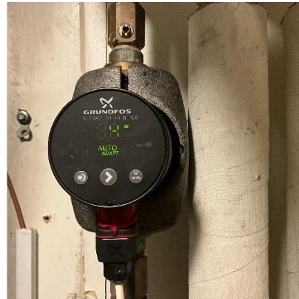
Cirkulationspumpe
