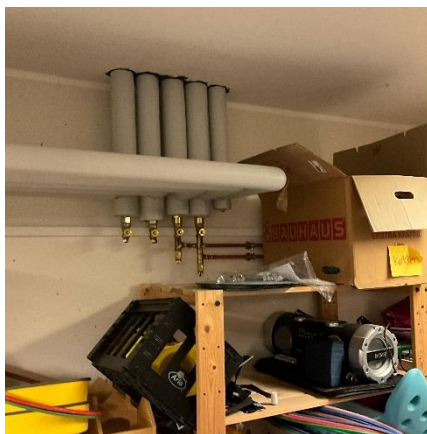
Rørføring i kælder til ny tilbygning
