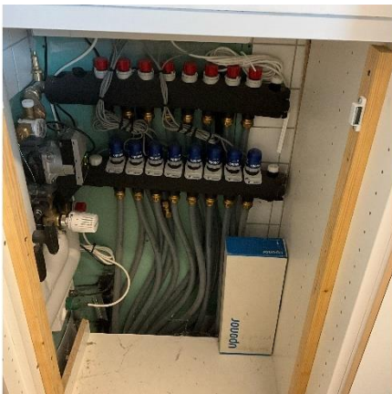
Gulvvarme installation ny tilbygning
