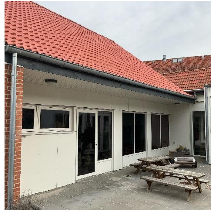
Facade ny tilbygning
