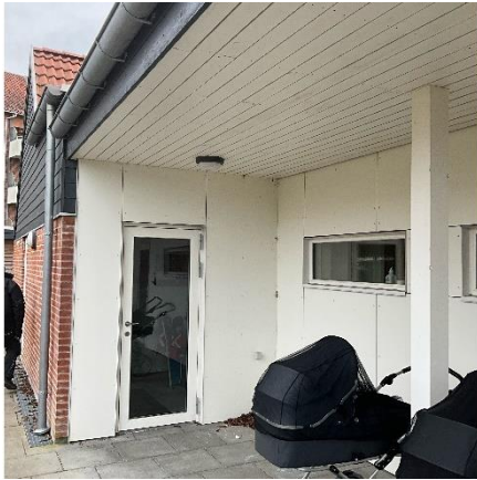
Yderdør i ny tilbygning
