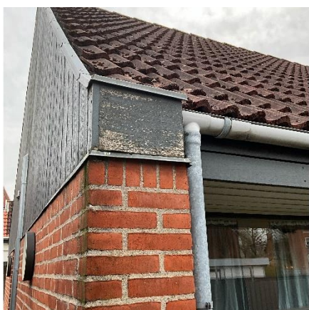
Vindskede og gavlbeklædning mod øst
