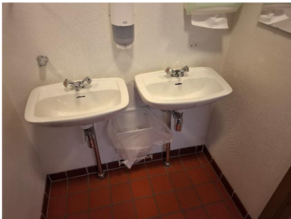
Sanitære forhold i toiletrum for personalet
