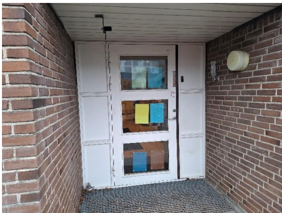
Oprindelig trædør med sidepartier
