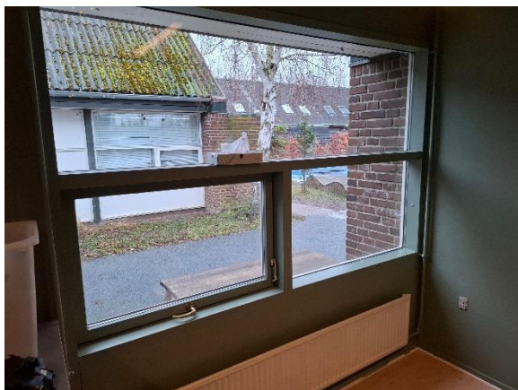
Vinduer i stue
