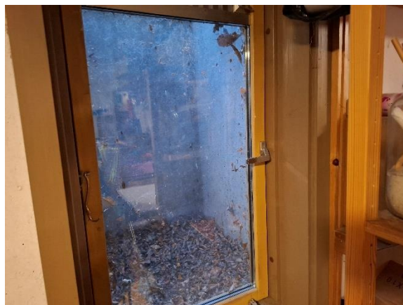
Vindue i kælder
