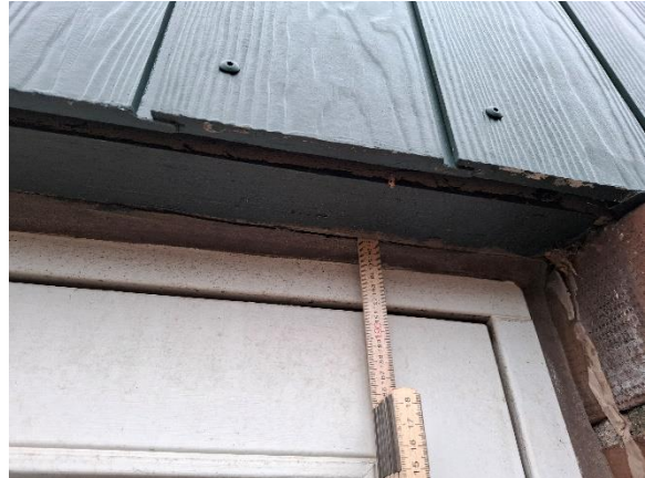
Fugeslip, dør i gavl mod syd
