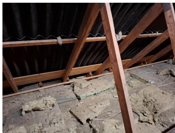
Mod uudnyttet tagrum, 300 mm mellem spær
