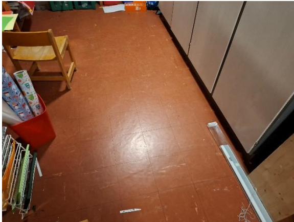
Gulv i kælder
