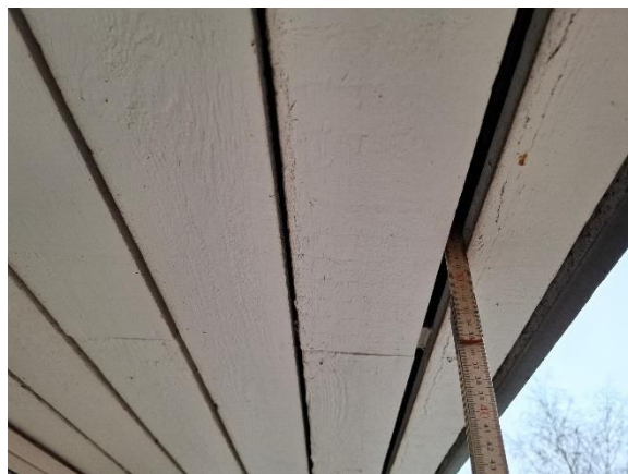
Udhængsbrædder uden fuglenet.
