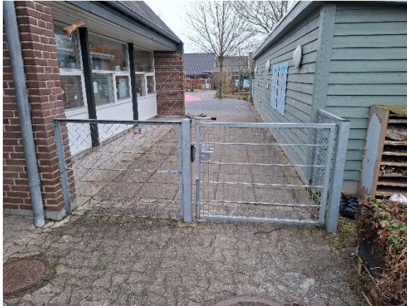
Låge ved gennemgang mod nord.
