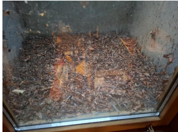
Manglende oprensning lyskasse
