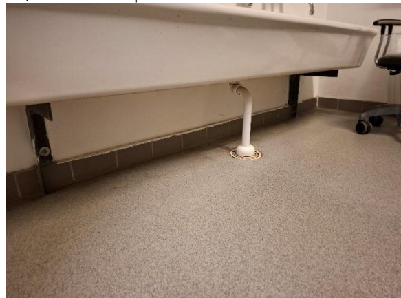
Afløbsinstallation i toilettrum i stueetagen.
