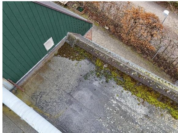
Flade tagflader ved afløb
