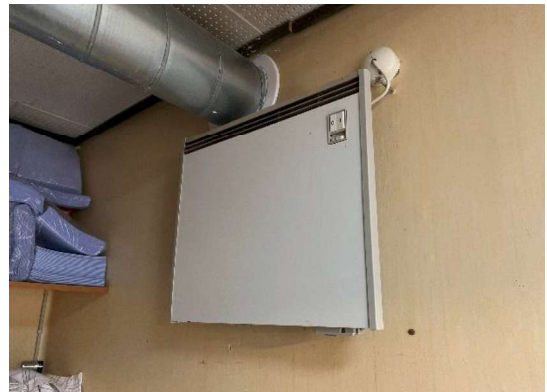
Gammelt el-panel til opvarmning af depot.
