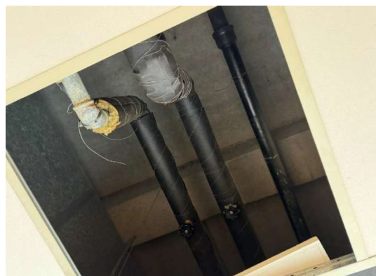
Oprindeligt afløbsrør i støbejern med tæring. Oprindeligt afløbsrør over nedhængt loft.
