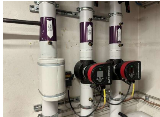
Nye pumper er monteret.
