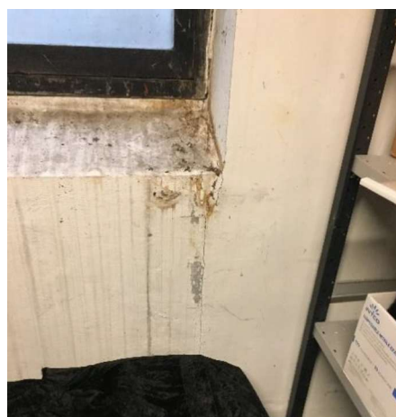
Gl. vandskade ved kældervindue
