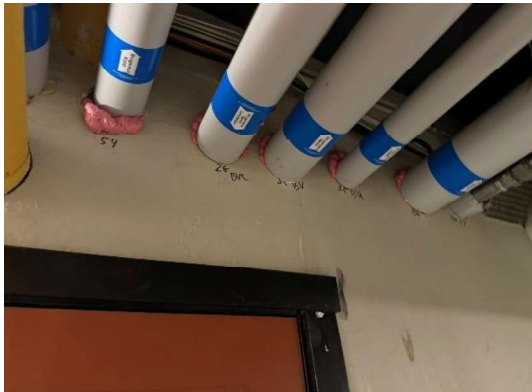
Nye hovedledninger i kælder
