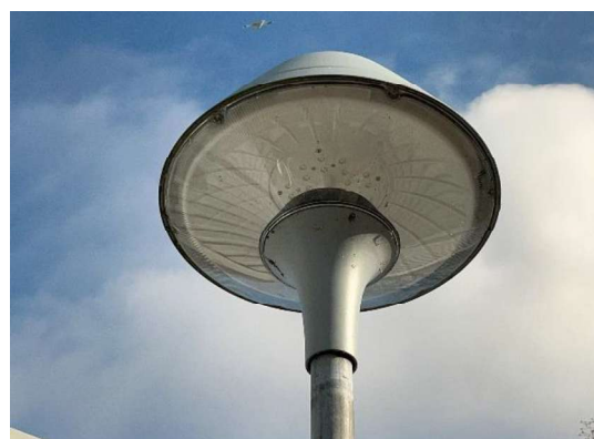
Der er blevet udskiftet armaturhoveder på masterne, til nye med LED-lyskilder.
