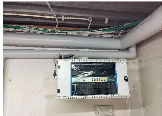
Krydsfelt i varmecentralen, også her uden ordentlige føringsveje.
