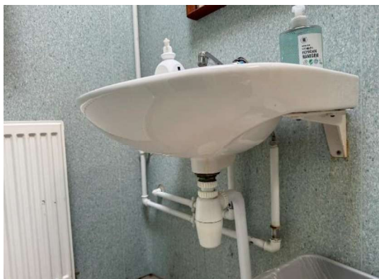
Koblingsledninger til vask i galvaniserede stålør. Vandvarmer til toiletter/bad i galvaniserede stålør.
