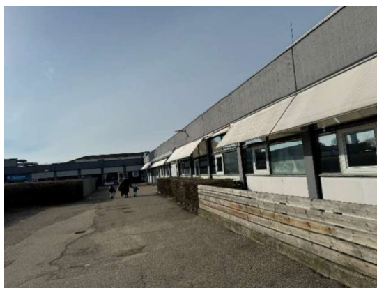
Mange revner i asfaltbelægning
