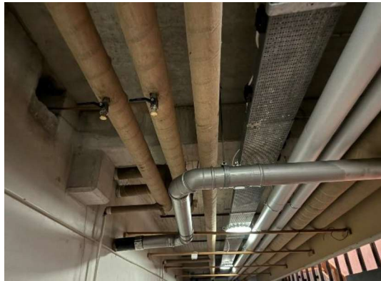
Vandledninger i kælder med afgrening i kobber Rørføring i krybekælder
