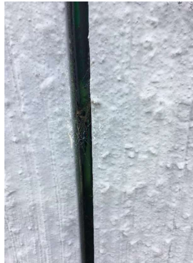
Facade sandwichelement, fugebånd i elementsamlinger
