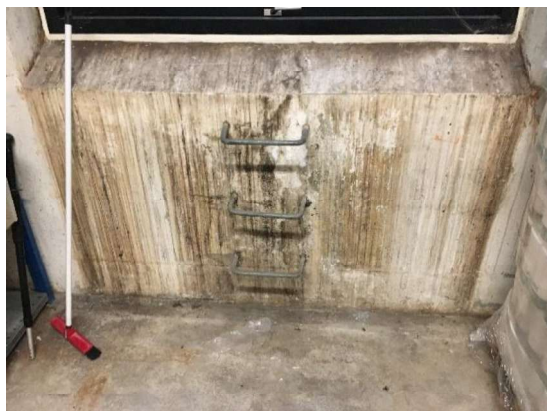
Gl. vandskade ved kældervindue
