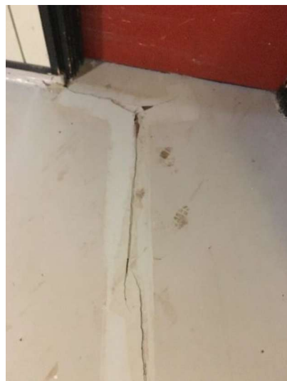
Kældergulv, betonslidlag
