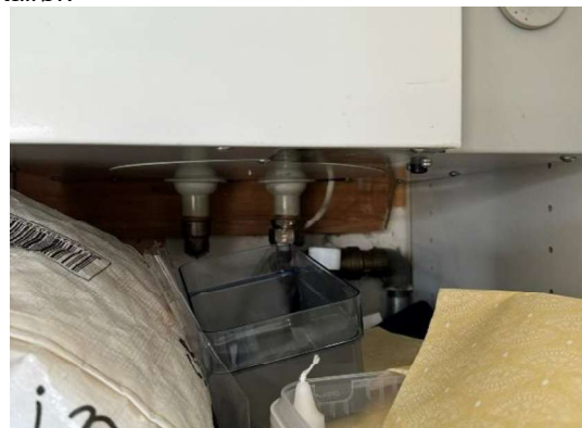
Koblingsledninger til vask i galvaniserede stålør. Vandvarmer til toiletter/bad i galvaniserede stålør.
