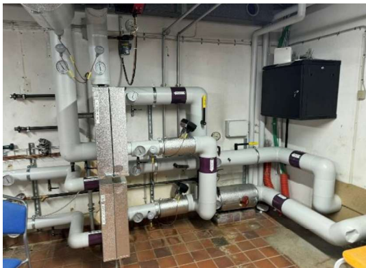
Varmecentral er nyistandsat.
