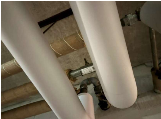
Vandledning (antaget) med reparationsklemme Vandledninger med afgrening i PEX
