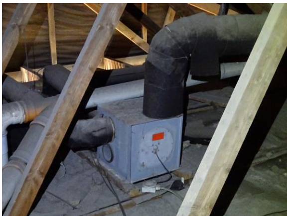
Boksventilator på loft, kontorbygning
