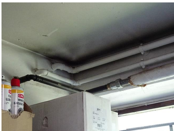
Uisolerede varmtvandsrør
