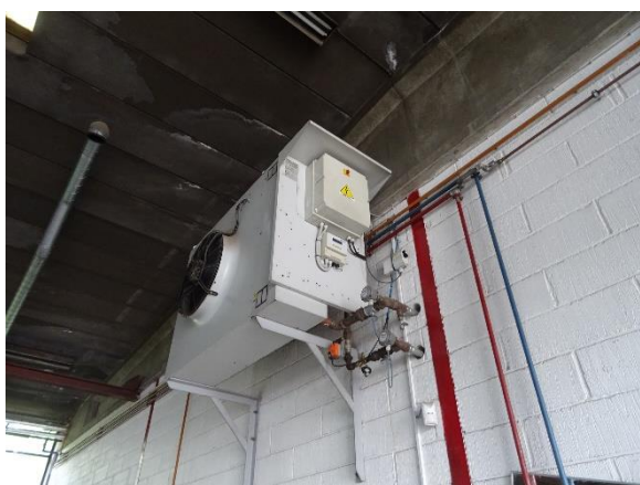
Tørkøler som varmeblæser i maskinhal
