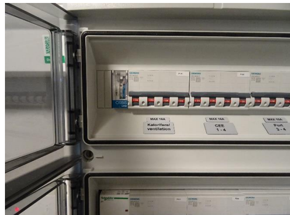
Kontaktur i eltavle til kaloriferer
