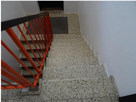
Kældertrappe i kontorbygning
