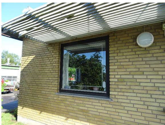
Vindue med termorude fra opførelsen
