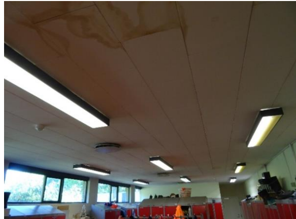
Omkledning, ældre armaturer med LED rør
