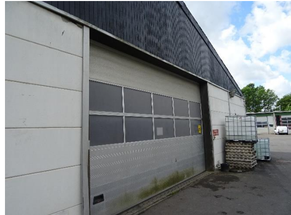
Port i nordgavl, saltlager
