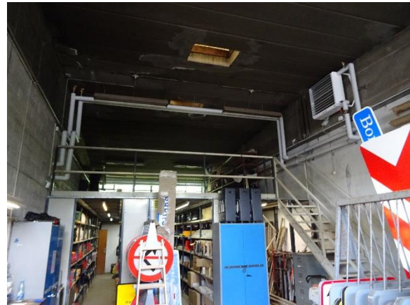
Ståltrappe til mezzanin
