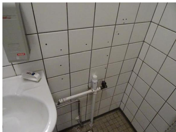
Fliser hullet efter tidligere ophæng
