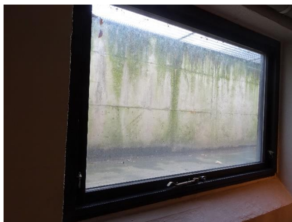
Kældervindue med et lag glas
