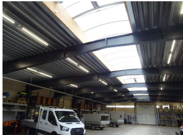
Ny hal, asfaltgulv, lette/træbeton vægge og ståltrapez-plade loft
