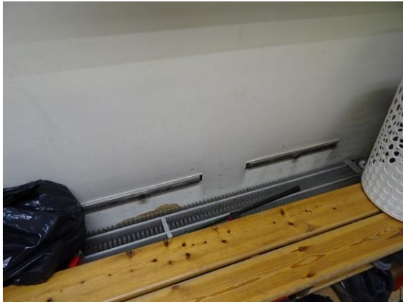
Ventilationsspalter i vægge, kontorbygning
