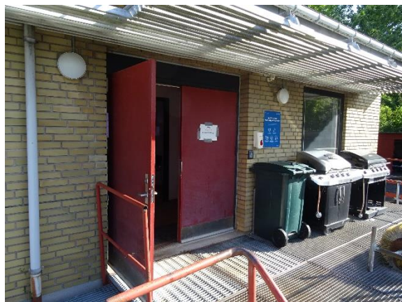
Øst indgang kontorbygning
