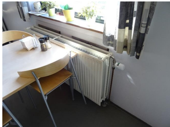
Udskiftet radiator i kantine
