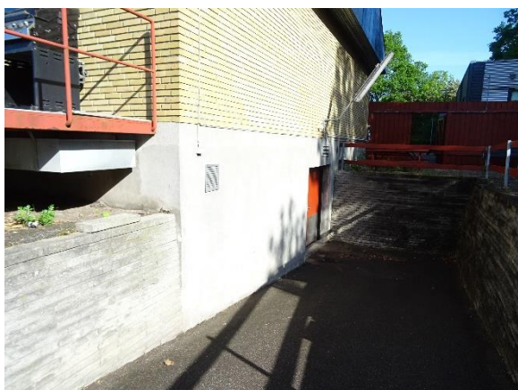
Kælderydervæg mod øst
