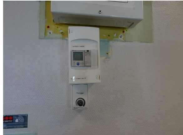
Manuel urstyring og potentiometer udsugning toiletter
