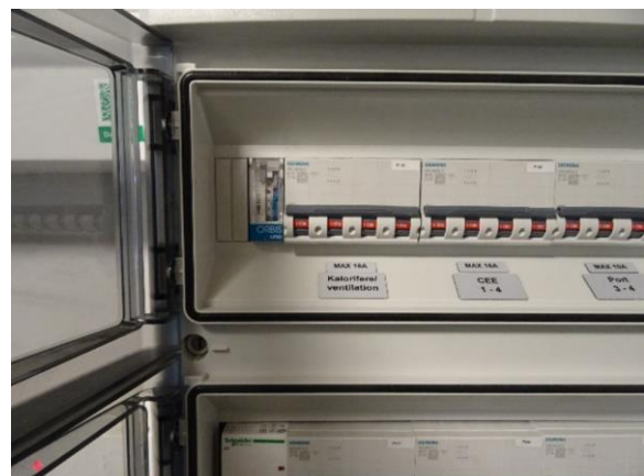
Analogt tidskontaktur for kalorifere
