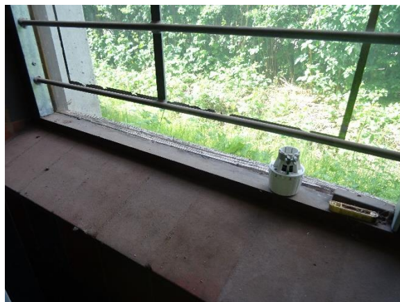
Et lags vindue i værkstedbygning
