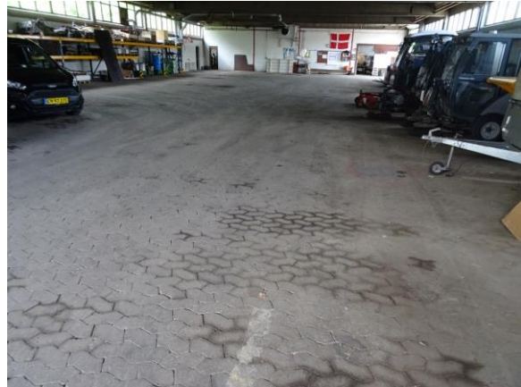
SF-sten i sydlig ende af værksted og gasbetonblok vægge
