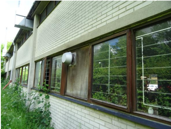
Vestfacade i kalksandsten
