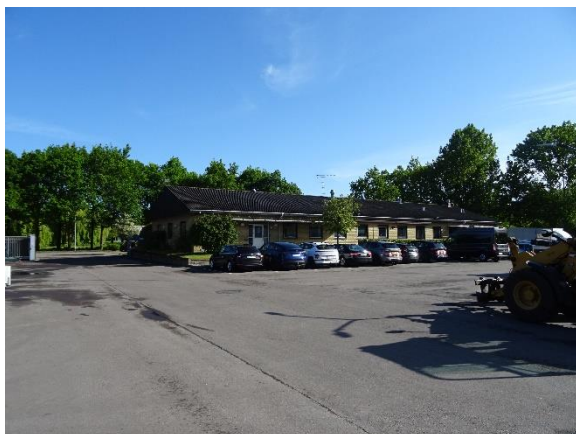
Asfaltbelægning, generelt god stand
