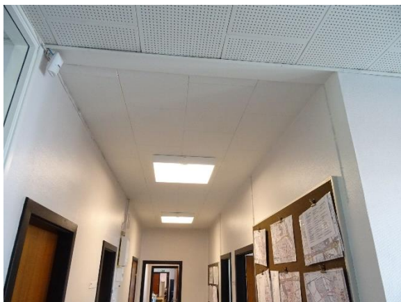
LED paneler med sensor
