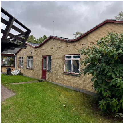
B4 Facade i tegl fra husets opførelse
