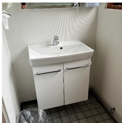
B6 Armatur m. automatik
