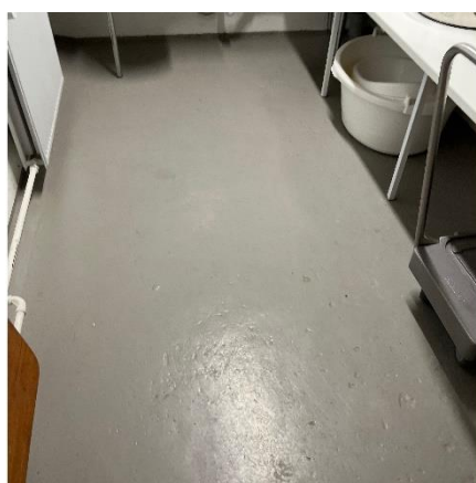
B7 Malet betongulv
