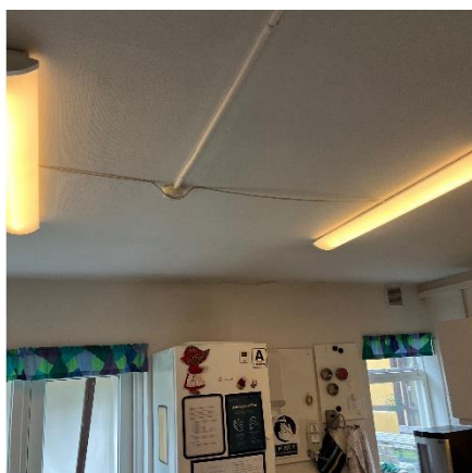
B4 Belysning vurderet med T5-rør m. højfrekvente forkoblinger
