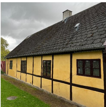
B6 Bindingsværk opr. fra 1880
