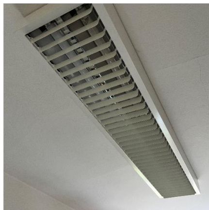
B4 Belysning med T8 og konventionelle forkoblinger
