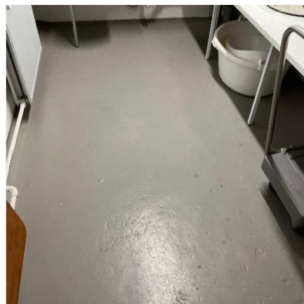
B7 Malet betongulv
