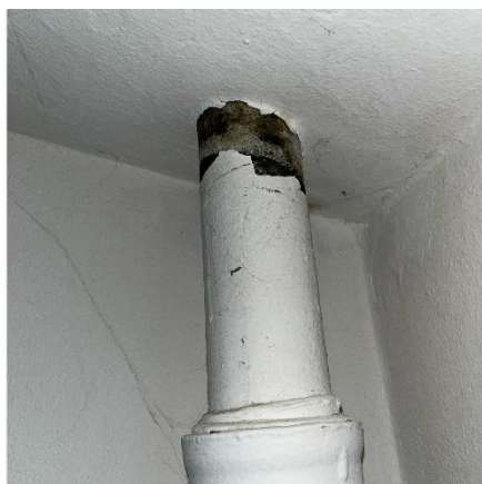
B4 Faldstamme formodentlig m. blymaling
