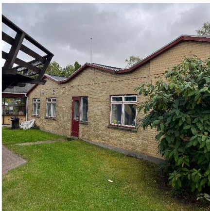
B4 Facade i tegl fra husets opførelse
