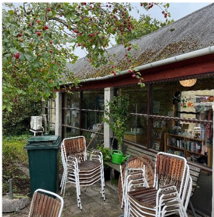
MI. bygning murpiller i tegl
