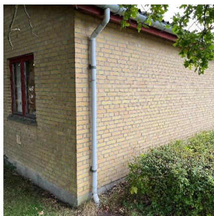
B7 Tagrende zink og nedløbsrør i plast
