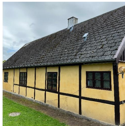
B6 Fibercement m. mosbegrøning
