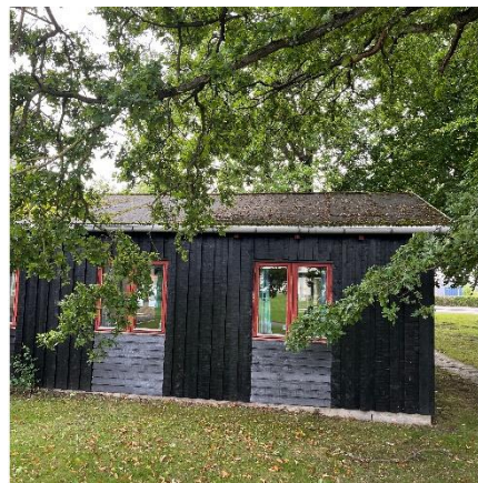
B4 Tilbygning i træ fra 1989
