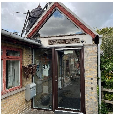
Ml. bygning dørparti m. trelags energiruder
