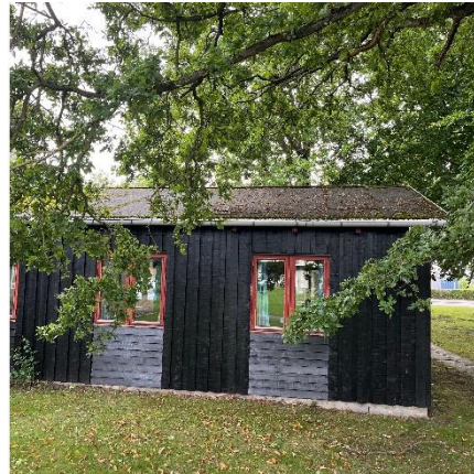
B4 Tilbygning i træ fra 1989
