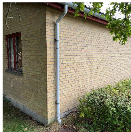
B7 Tagrende zink og nedløbsrør i plast
