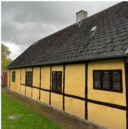
B6 Bindingsværk opr. fra 1880
