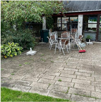
Ml. bygning Flisebelægning i terrasseområde
