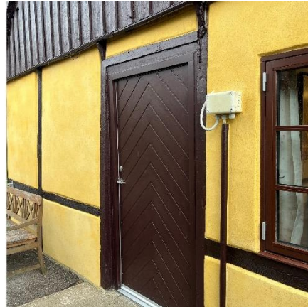
B6 Præisoleret pladedør
