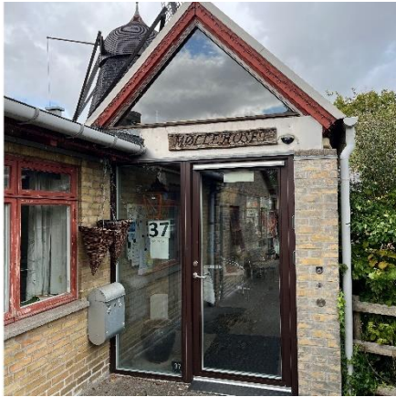
Ml. bygning dørparti m. trelags energiruder
