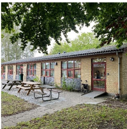
B7 Murstensfacade m. vinduesbrystninger i træ
