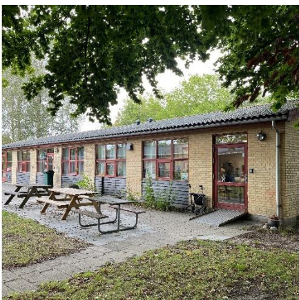
B7 Murstensfacade m. vinduesbrystninger i træ
