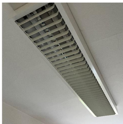
B4 Belysning med T8 og konventionelle forkoblinger
