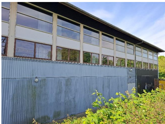
Facader på idrætshal beklædt med trapezplader i stål.
