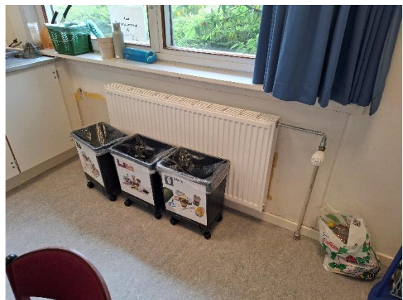
Udskiftet rør og radiator
