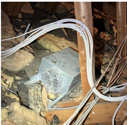
"Systemair" støvhætte fra produktion sidder stadig på studs til armatur.
