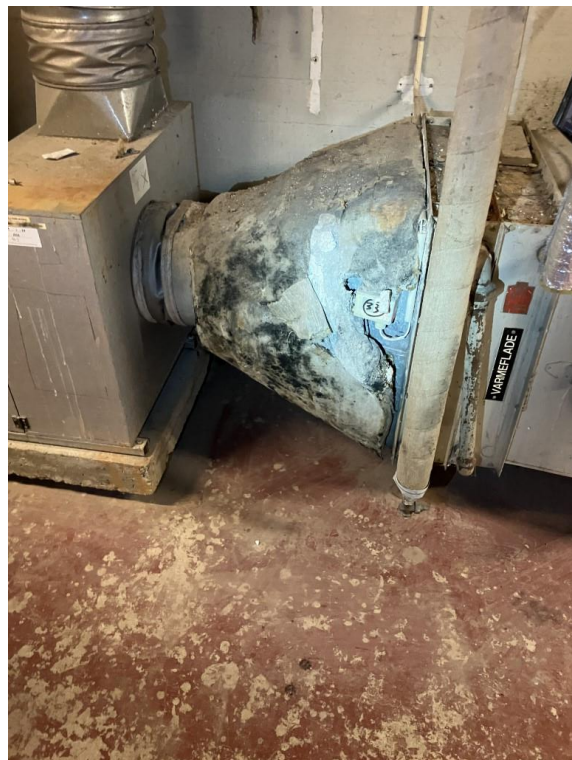
Ældre boksventilator. Varmeplade sidder på hvad der normalt vil være udsugning.
