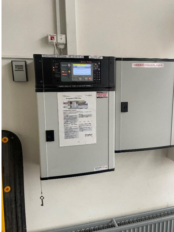
ABA-centralen placeret ved hovedindgangen
