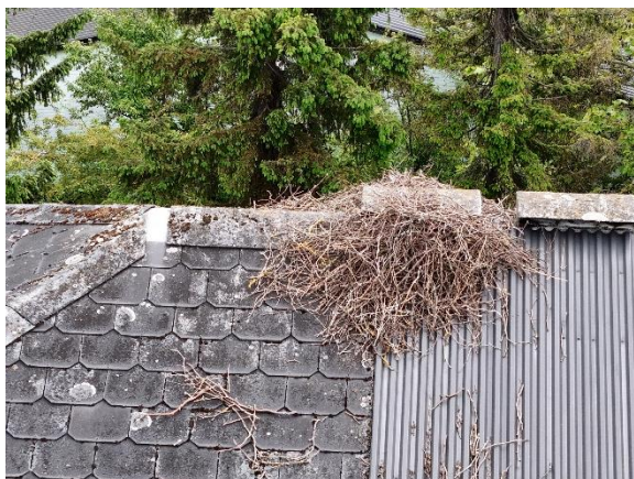
Fuglerede i udluftning på svømmehal. Rygning er ikke ført helt til grater.
