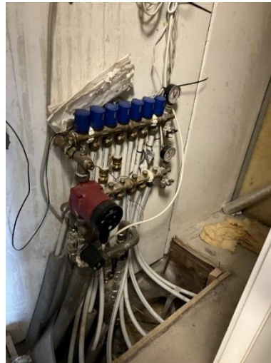
Gulvvarmestyrings manifold
