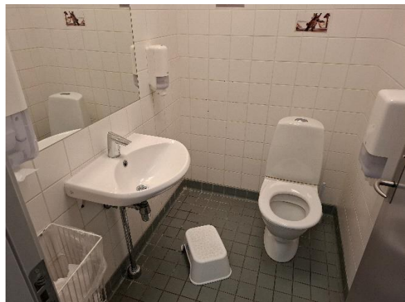
Dele af ejendommens vandinstallationer ført skjult.
