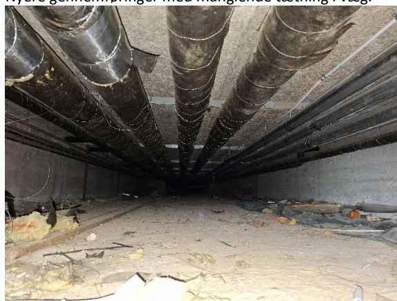
Krybekælder under mellemgang.
