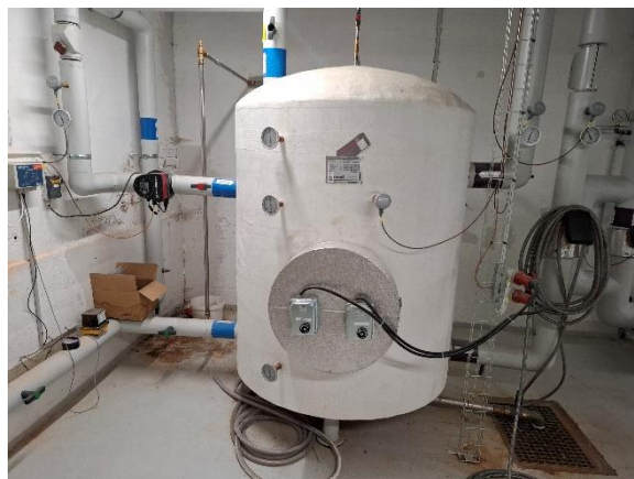
Varmtvandsbeholder med elpatroner
