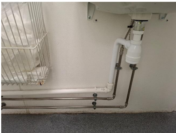
Rør udskiftet til rustfri installation
