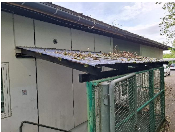
Overdækning med trapezplader til trappe til kælder under sundhedsplejen.
