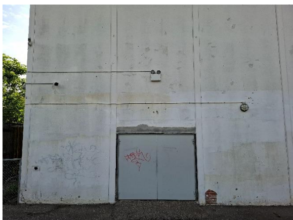
Gavle på idrætshal er med afskallende maling.
