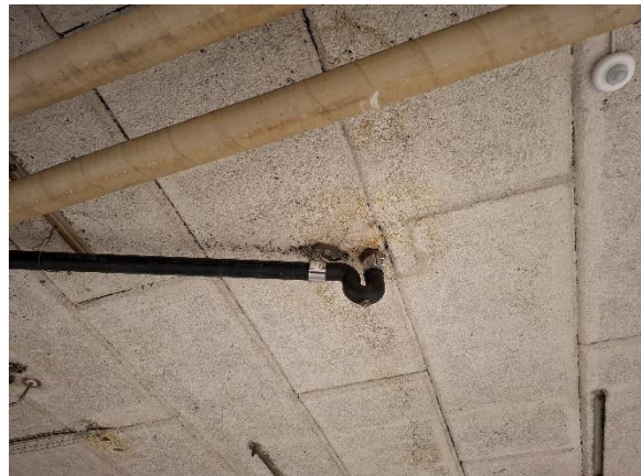
Løfter i kælder
