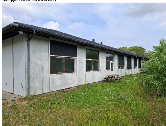
Betonsandwichelementer på øvrige dele af bygningen.
