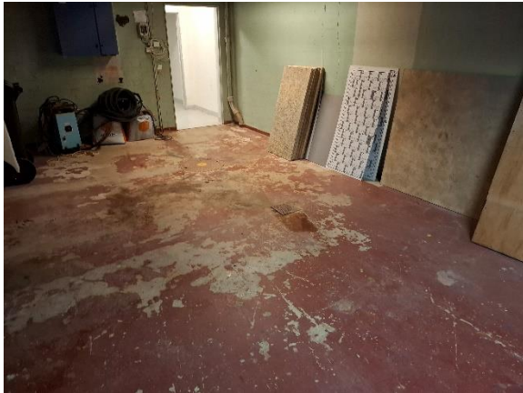
Slidt epoxymaling på betongulv i kælder
