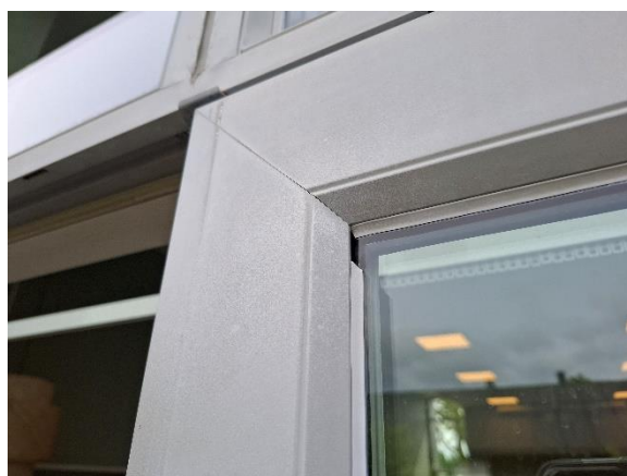
Glasbånd er gledet ned på træ/plast-vindue på sammenbygningen til multihuset.
