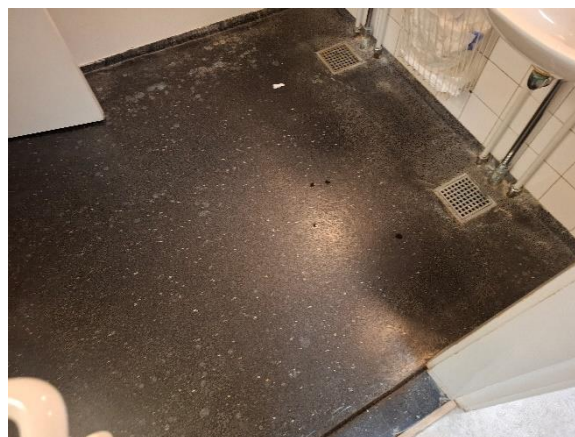
Galvaniseret rør fremført til vaske.
