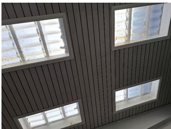
Ovenlys ved opgang til svømmehallens herreomklædning. Transparente bølgeplader og indvendig akrylplastplade.
