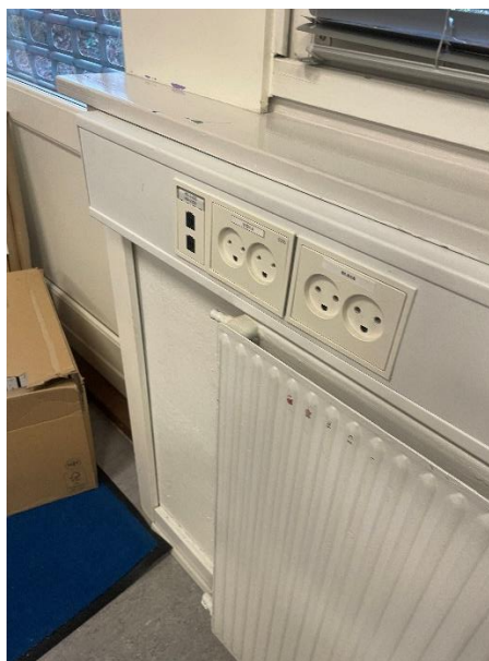
Installationsmateriel i kabelkanal i undervisningslokale, musikskolen.
