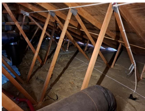
Tagkonstruktion i bygning B
