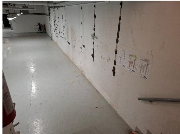
Kælderrum med varmecentral
