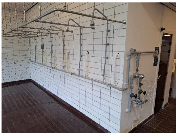
Brusere udført med fælles blandingsbatteri, tempostop bruseventiler og i galvaniseret stålør.
