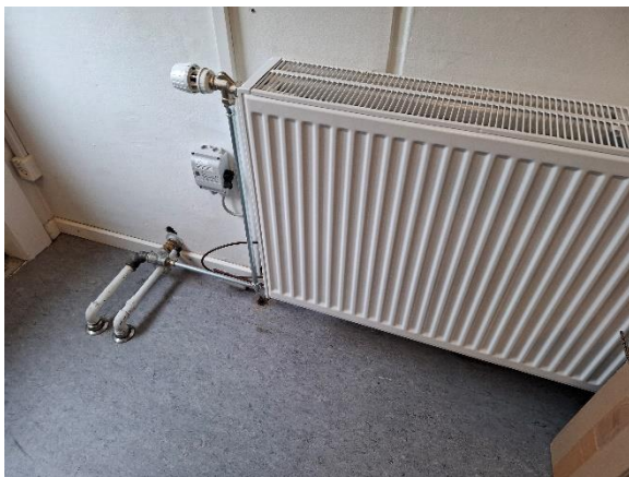
Radiatorer udskiftet enkelte steder
