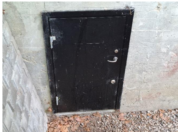
Flugtvejsdør i kældersakt fra 1974
