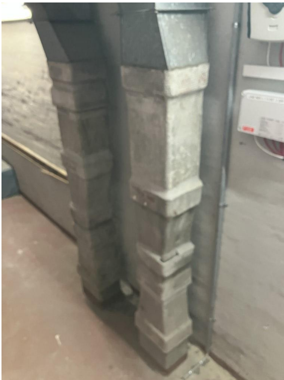
Kanalstræk i eternit, sandsynligvis asbestholdig
