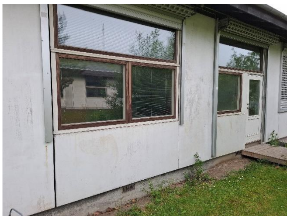
Pinolhængslede vinduer med fast overparti
