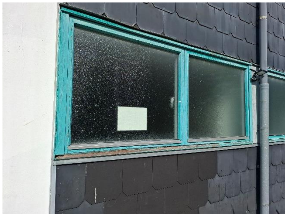
Fastkarmsvinduer på svømmehal
