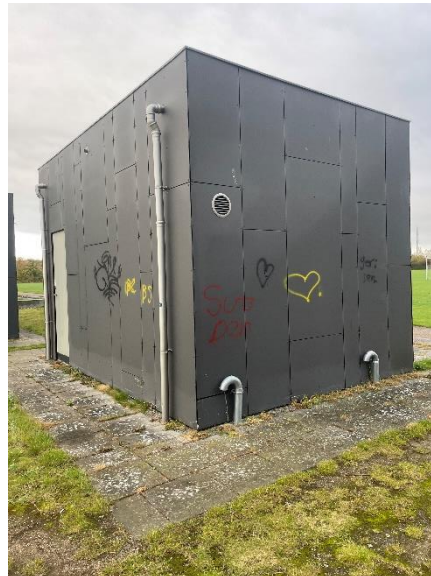
Belægningen set fra bygningens bagside
