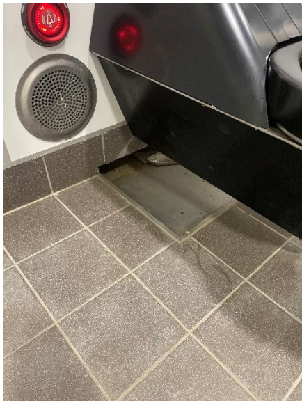
Afløb under toilettet
