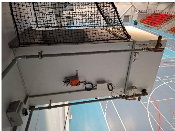
Varmeventilator i hal
