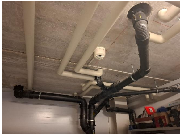
Rørføring i loft frem til tapsted
