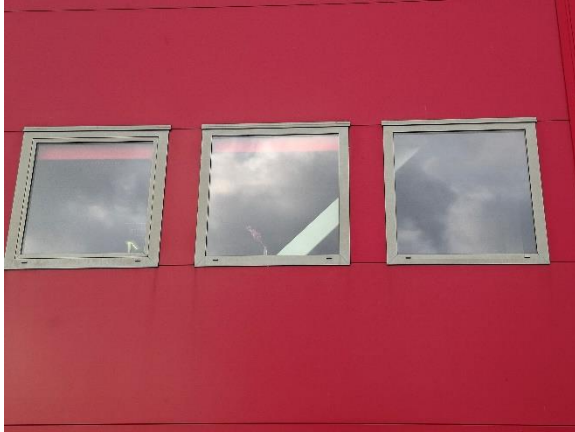
Vinduer i kantine
