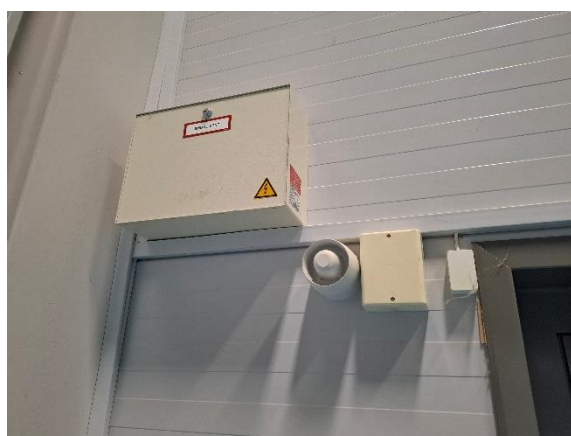
Automatik for røgudluftning gennem tagvinduer
