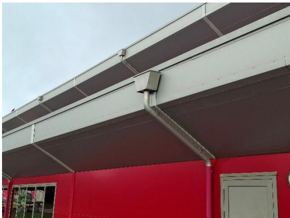
Vandsamlerkasser og tagnedløb
