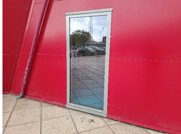
Vindue i indgangsbygning.
