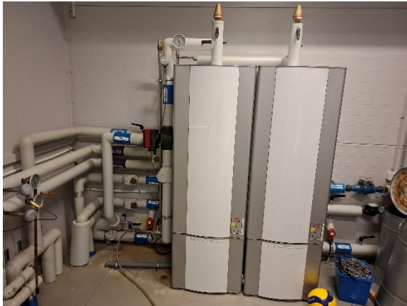
Metro varmtvandsbeholdere
