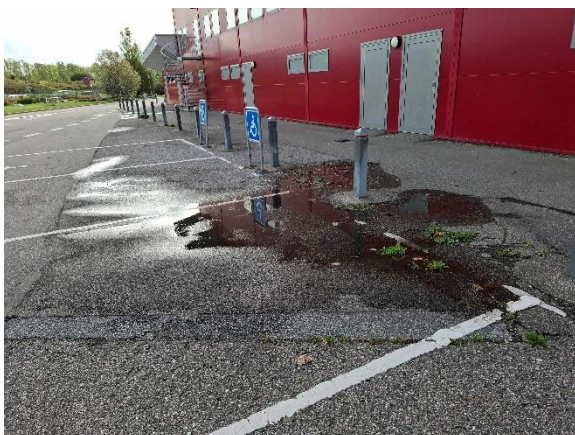
Asfaltbelægninger på parkering mod nordøst
