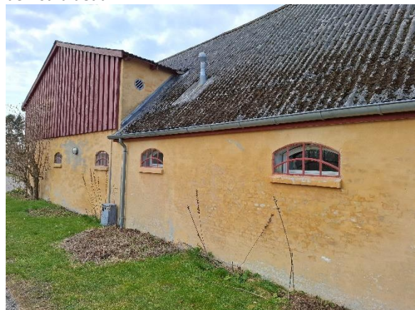
Terræn er ført over sokkel mod vest
