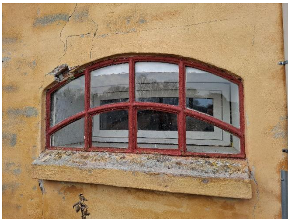
Gamle originale støbejernsvinduer med forsatsramme
