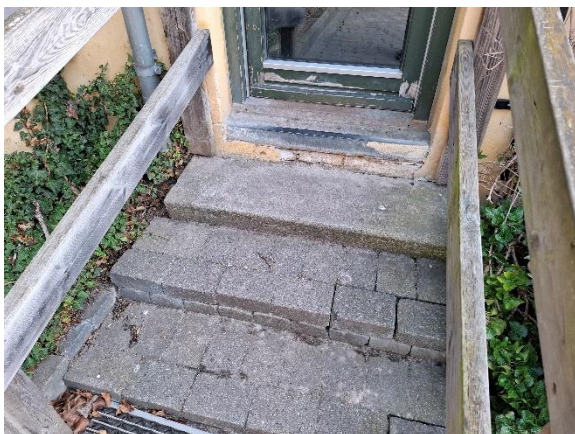
Trappe foran dør til baghus fra gård
