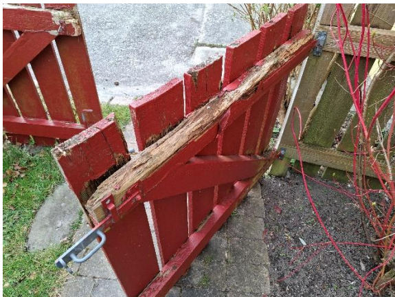
Trælåge mod øst er med nedbrudt træværk. Funktionen er begrænset.
