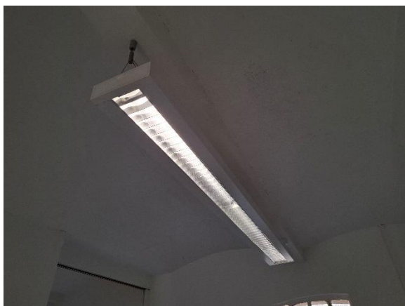
Rektangulært loftsarmatur med indbygget lysstofrør.
