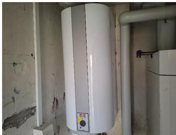
Varmtvandsbeholder
