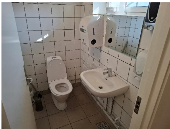
Toilet i bygning syd
