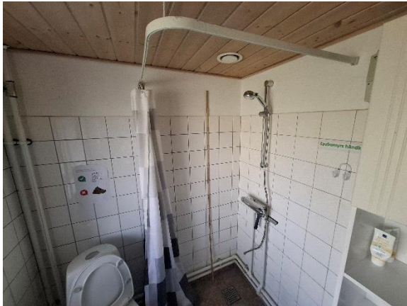
Toilet i bygning nord
