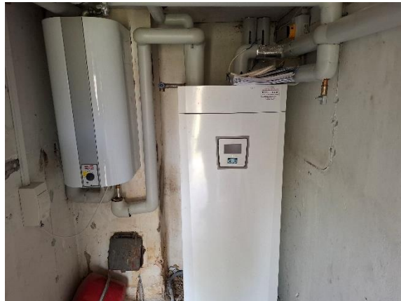
Inde del luft til vand varmepumpe inkl. varmtvandsbeholder
