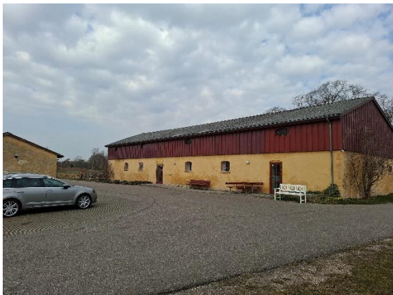
Asfaltbelægninger ved adgangsvej
