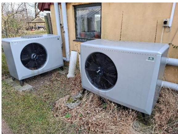
Varmepumpe, udvendige dele
