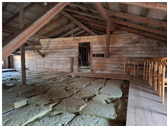
Loft isolering
