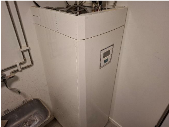
Varmepumpe til forhuset, vest- og østfløjen, indvendig del
