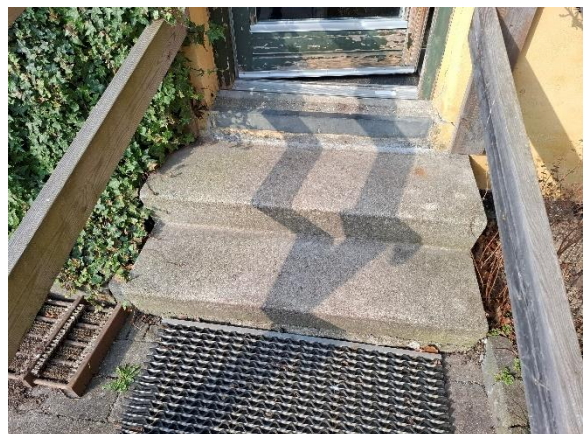
Trappe foran dør til baghus fra gård
