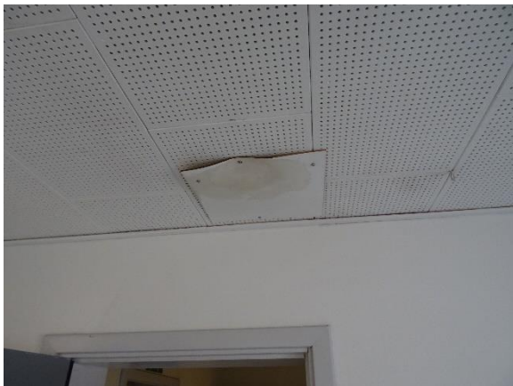
Opfugtet område på loft. + midlertidig lap
