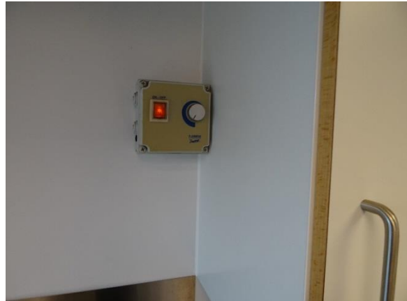
Potentiometer til emhætte styring
