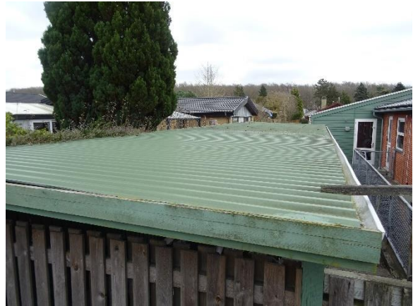
Overdækning bygning 3 nord
