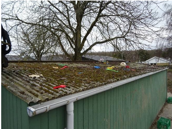
Udhus bygning 2 syd på legeplads
