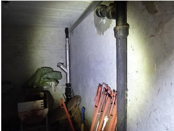
Støbejernsfaldstamme med rustfri i baggrunden
