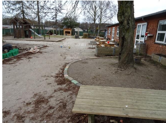
Asfalt på legeplads
