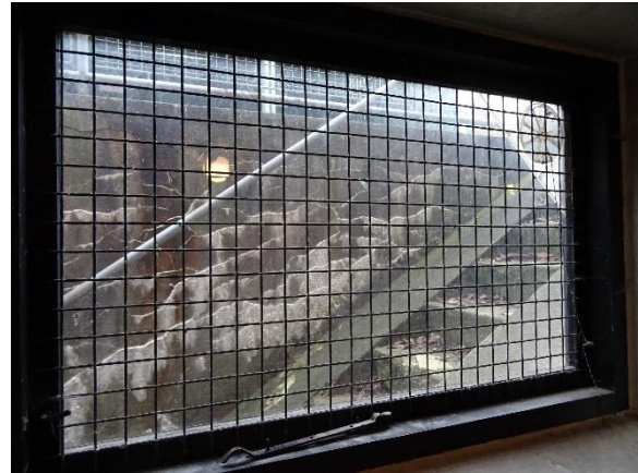
Kældertrappe set fra kælder
