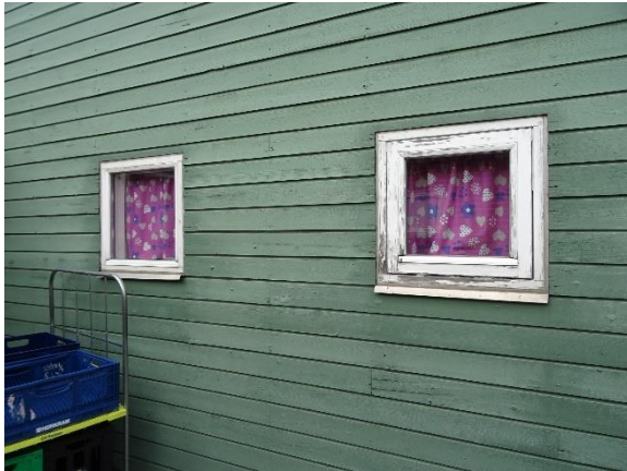
Vinduer i liggehal
