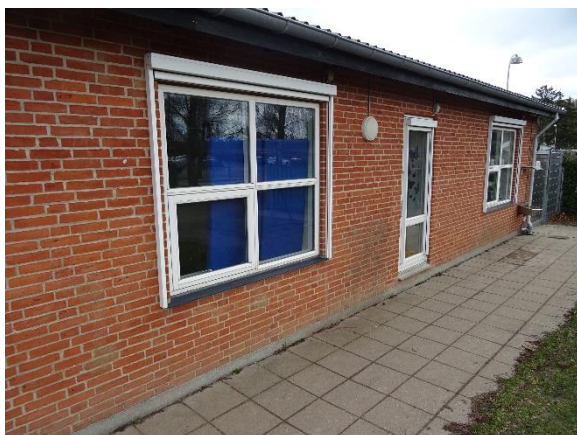
Vinduer i træ på tilbygning
