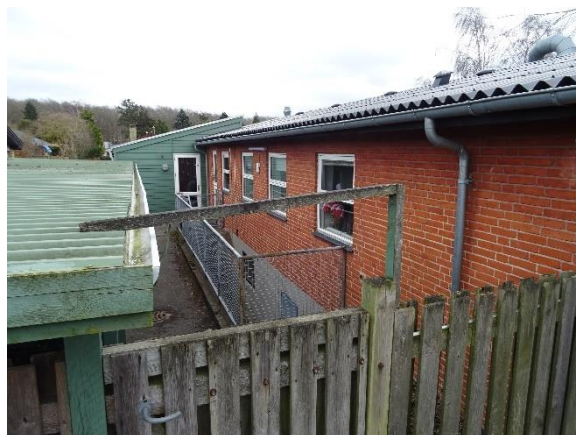
Facade over kældertrappe
