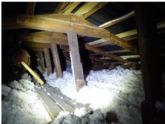
Glasuldsgranulat på loft
