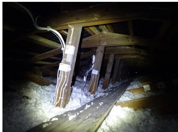
Glasuldsgranulat på loft
