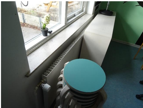
Radiator, 1 lag på stue
