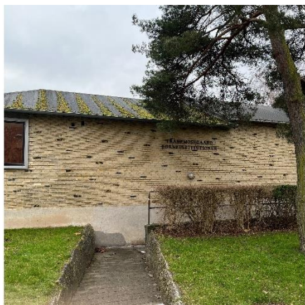
Mosbegrøning på tagflade mod nord bl.a. pga. bevoksning
