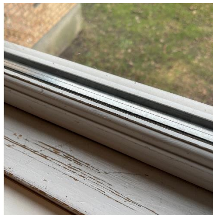
Vindue med termorude i stueetage
