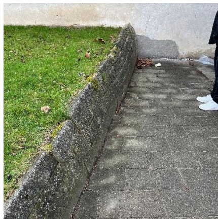
Lav støttemur ved rampe
