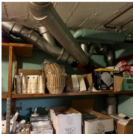
Afløbsrør med blyholdig maling
