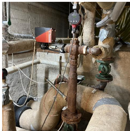
Træring af rør
