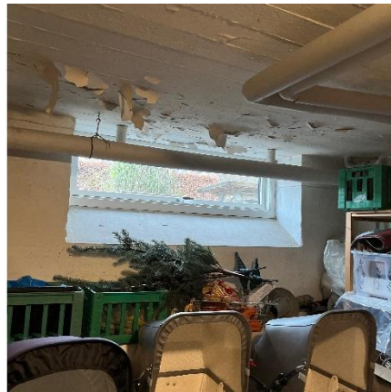
Tolags energiruder med varm kant ud mod gård
