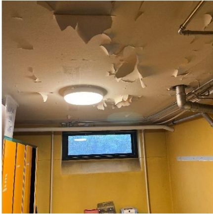
Loft i kælder
