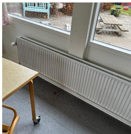
Panelradiator på let brystning
