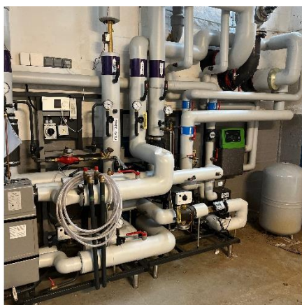
Ny fjernvarme-unit med gennemstrøms brugsvandsveksler og varmeveksler.
