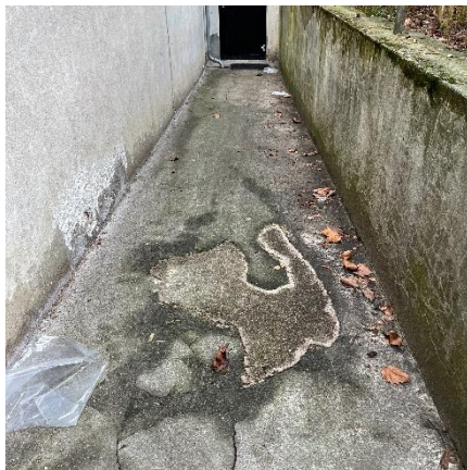
Rampe til kælder
