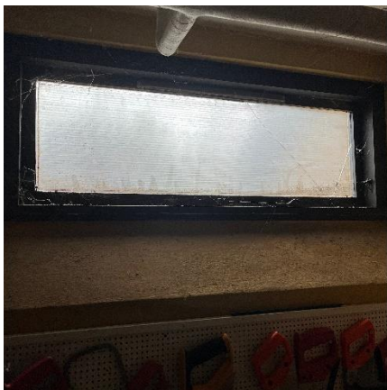
Vindue med etlags glas i kælder
