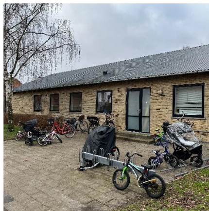
Vinduer i bygning mod SØ
