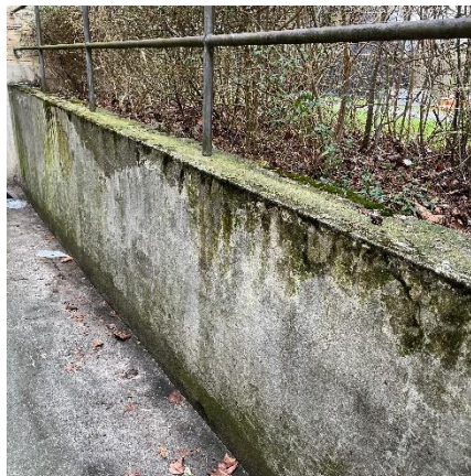
Støttemur ved kælderrampe
