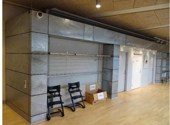
Stålplade beklædning indvendigt
