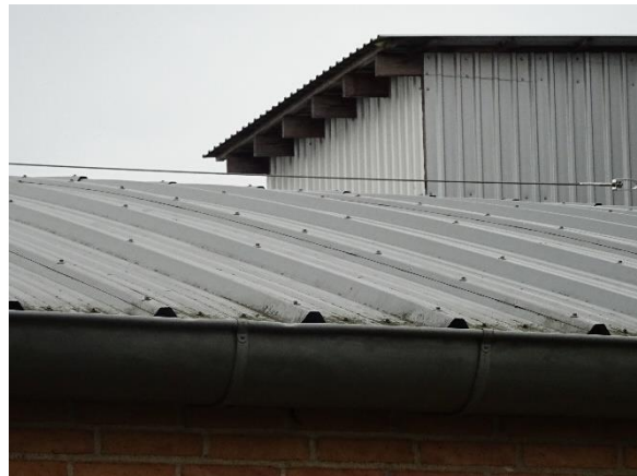
Ståltag på kulturhuset nord
