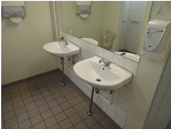
Håndvaske med oprindelige to-grebs armaturer
