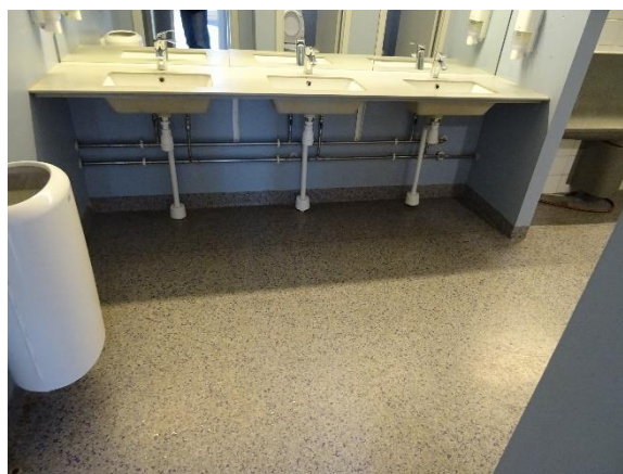
Toilet forrum med nyere vaskearrangement. Rør er udskiftet.
