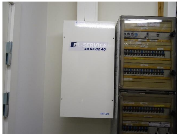
NOP central med indbygget batterier
