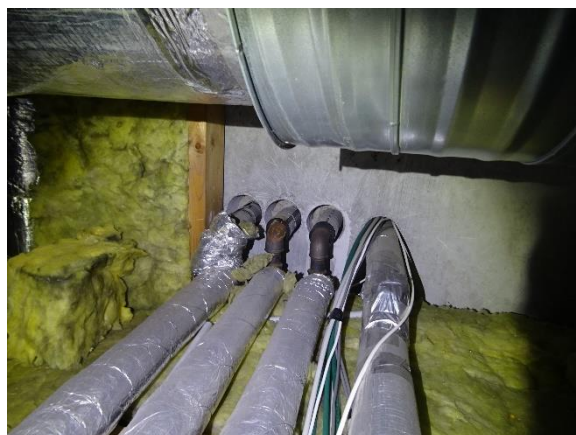
Varmerør over loft
