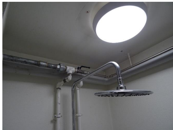
Reparation / knopskydning fra galvaniseret til rustfri
