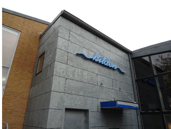
Gavl. Stålblader facadebeklædning
