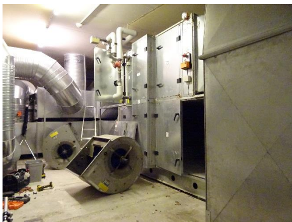
Ventilatorer for kulturhuset under udskiftning
