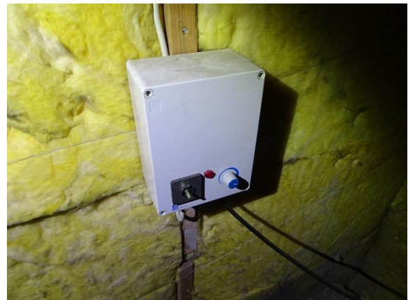
Styring udsugning, fast hastighed uden tidsstyring
