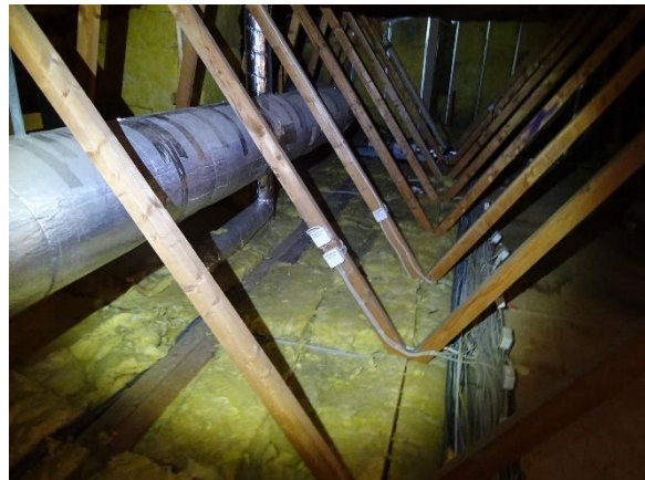
Isolering loft over teatersal
