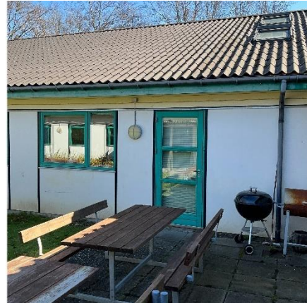
Tagrender i plast og sternbrædder.
