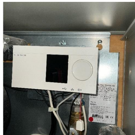
Automatik m. vejrkompareret fremløbstemp.
