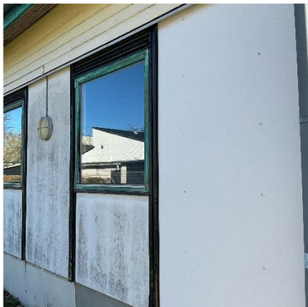
Vinduesfacade mod vest
