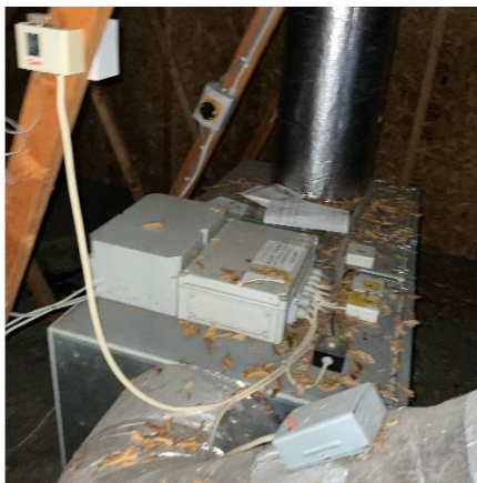
Ventilation på loft
