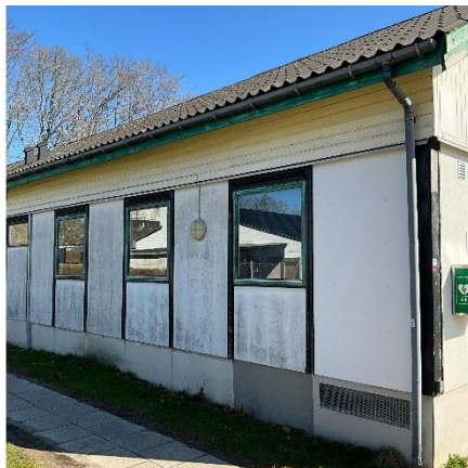
Sokkel i fibercement, facade i fibercement med lister i samlinger.
