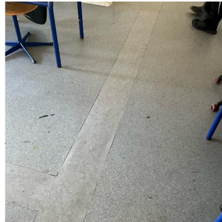
Brudte svejsninger i linoleumsgulv
