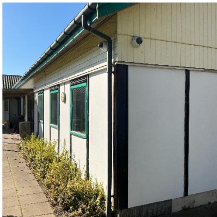
Facade med fibercementplader
