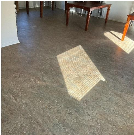
Linoleumsgulv i undervisningsrum
