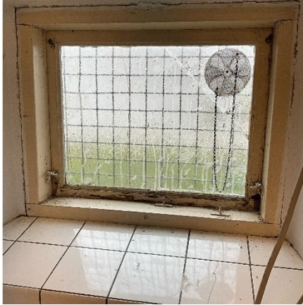
Etlags vinduer i kælder
