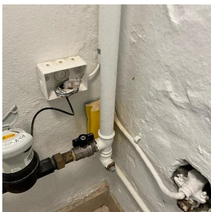
Dæksel til membrandåse mangler
