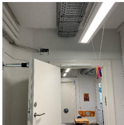
LED belysning med indb. sensor
