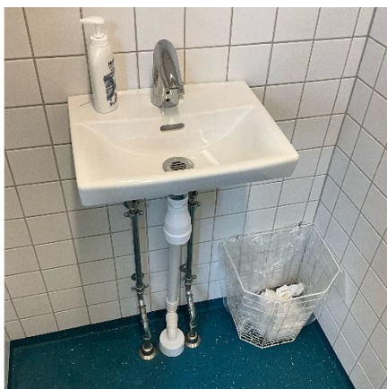
Personalehåndvask tilsluttet med rustfri stålør
