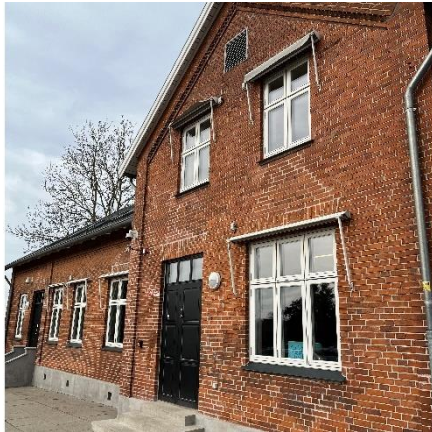
Indgangsparti med bevaret trædør
