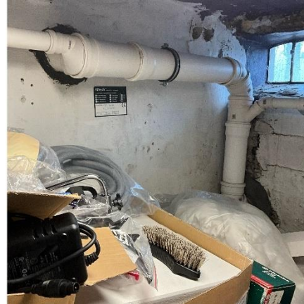
Afløbsrør i kælder
