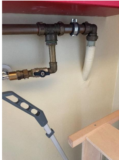
Synlig rørinstallation under slangevinder
