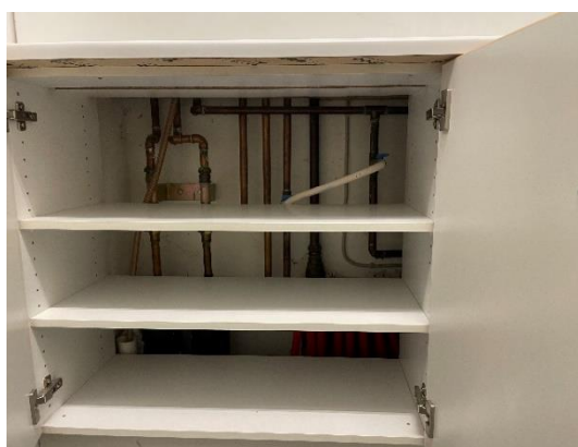
Varmerørsinstallation gemt bag opskruet let væg
