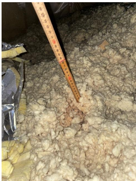
Isolerings tykkelse ved loftlem
