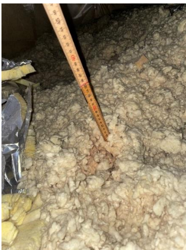
Isolerings tykkelse over loft målt til 200 mm
