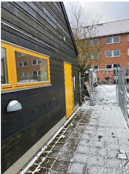
Belægningen set fra bygningens endegavl
