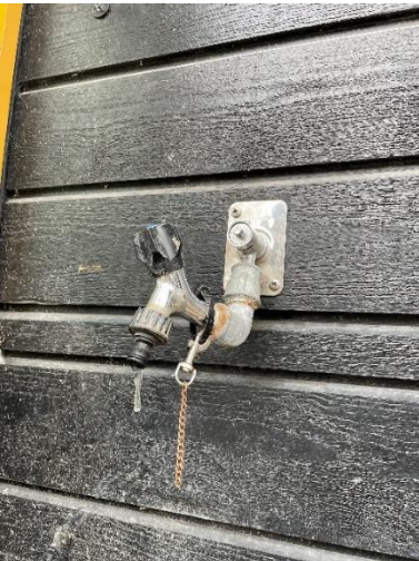
Udvendig vandhane sidder efter frostsikring
