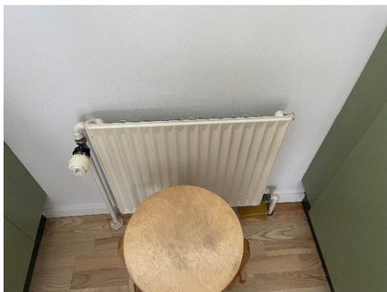
Radiator til 2 strengs system
