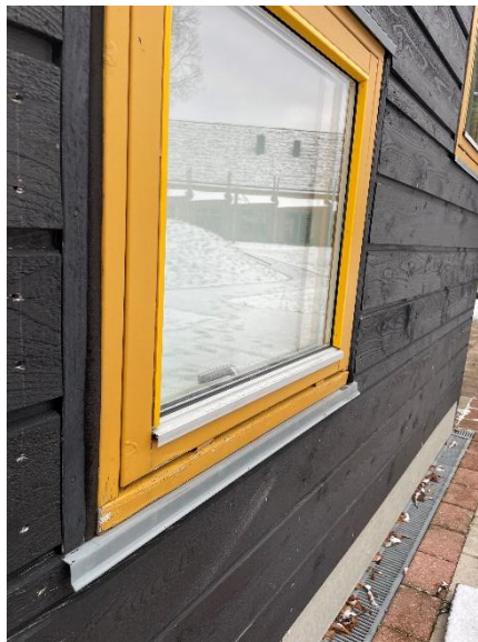
Standen af rammen er generelt slidt i bunden
