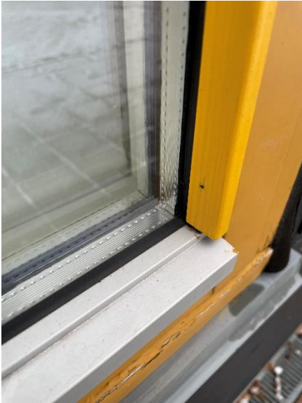
Billede af 2 lag termorude med kold kant og slidt ramme
