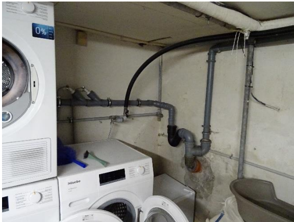
Afløb fra vaskekælder
