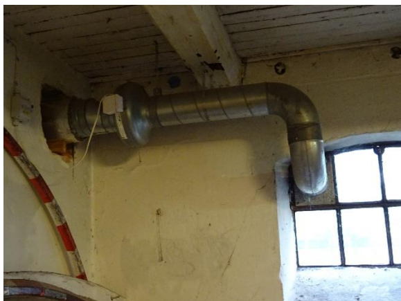
Kanalventilator hos BRC
