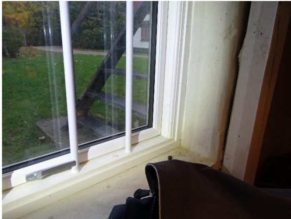
Kældervindue med energirude m. varm kant
