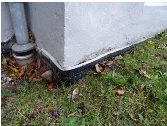
Udvendig drænplade på kælderydervæg
