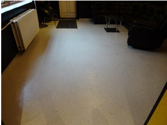
Epoxy gulv i vestlænge
