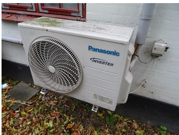
Varmepumpe, udedel
