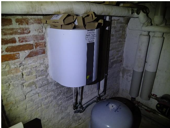
Varmtvandsbeholder til stuehuset
