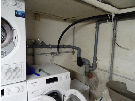
Afløb ender i PVC kloakledning
