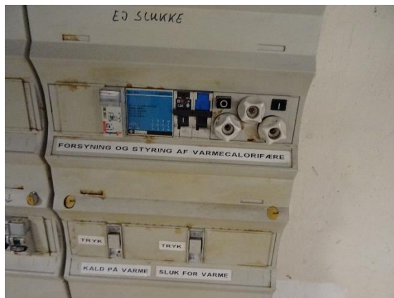
Styring kontaktor for kalorifere i BRC
