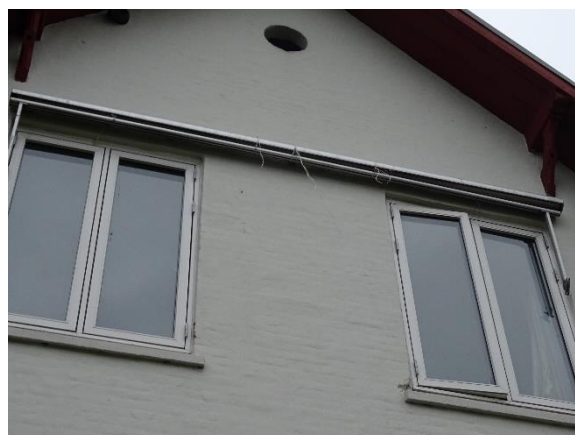
Vinduer i gavl, træ/alu
