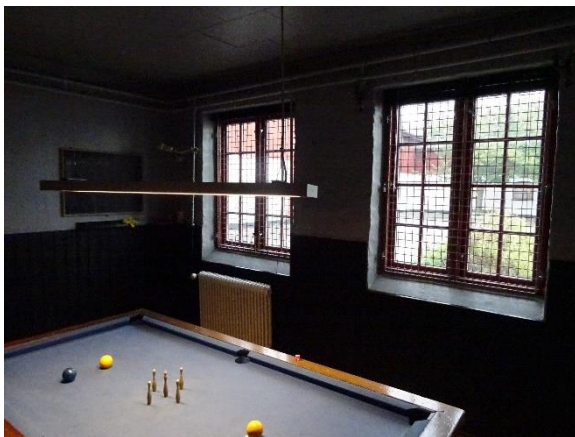
Vinduer i vest længe med energirude m. kold kant fra 2002
