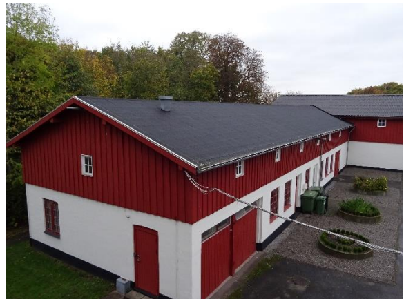
Tag på vestre længe og trempelbeklædning. Ved historiske skråfoto ligner det også at denne længe har fået tagrenovering før 2017.
