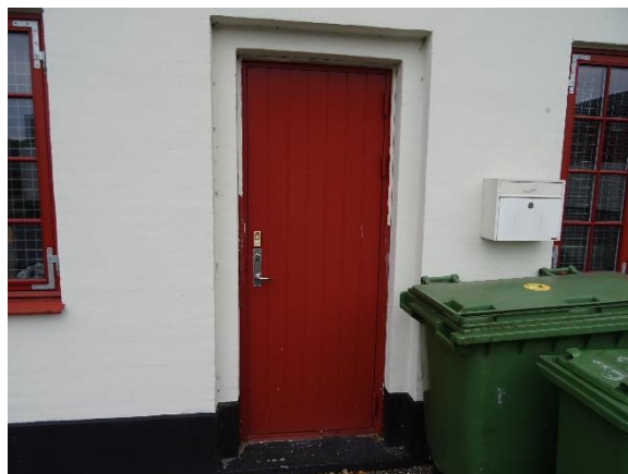
Pladedør til vestlængen
