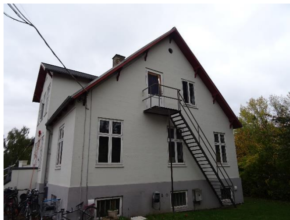
Sikkerhedstrappe på gavl
