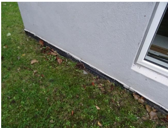
Drænplade på kælderydervæg
