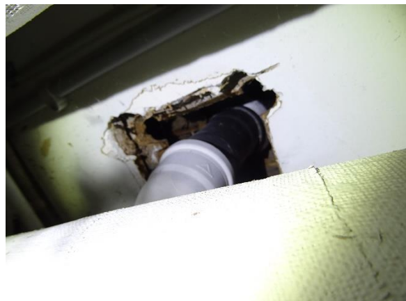
Plast gennemføring til stueetagen
