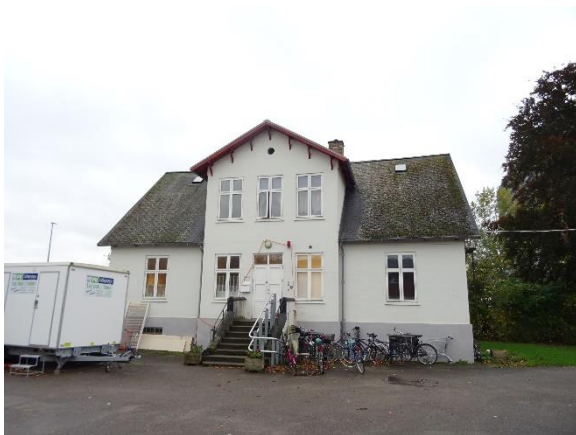
Stuehuset set fra nord
