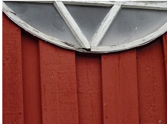
Hexagram kvistvindue med nedbrydning af træet
