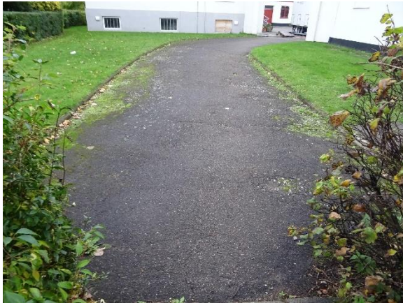
Asfaltsti fra Roskildevej
