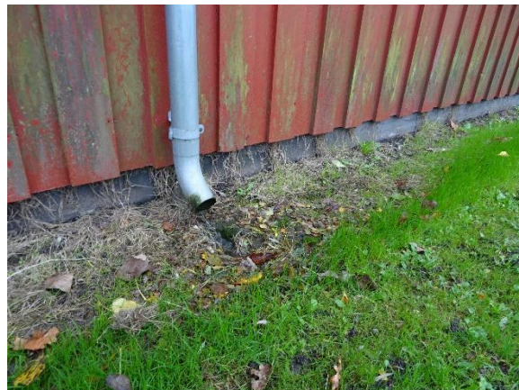
Et af mange tagnedløb der afvander direkte foran sokkel
