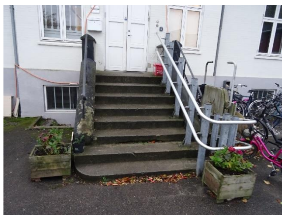
Hovedtrappe i beton
