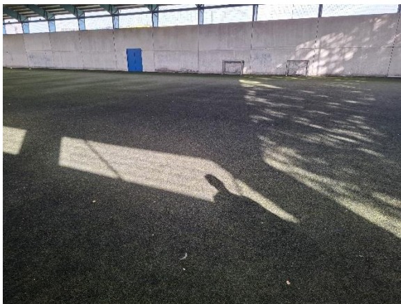
Belægninger i hallen
