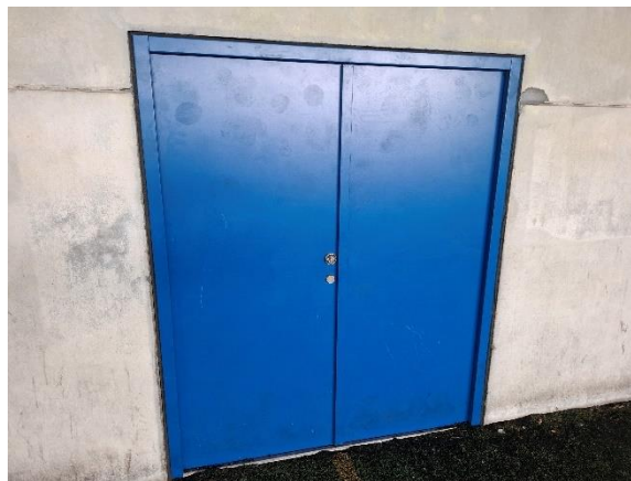
Dør i nordvendt facade
