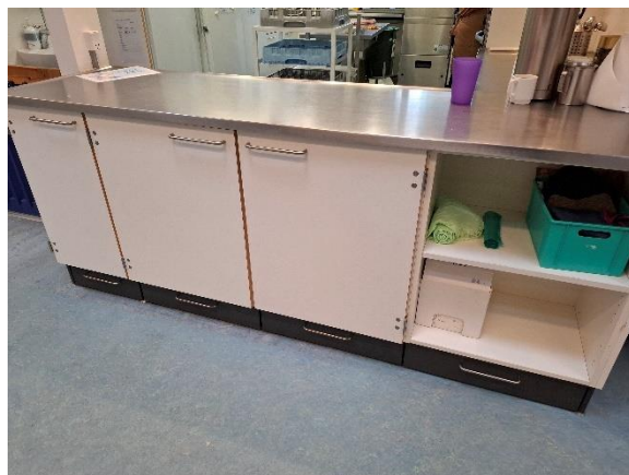
Køkkenelementer med stålboardplade
