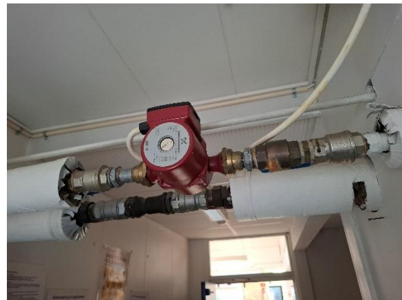
Cirkulationspumpe af ældre dato
