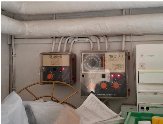
Udekompenseringsanlæg
