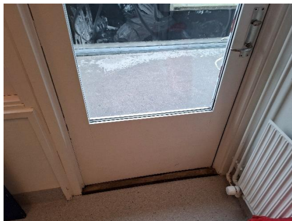
Dør til hovedbygningen
