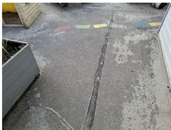
Asfaltbelægninger med tætning i samling.
