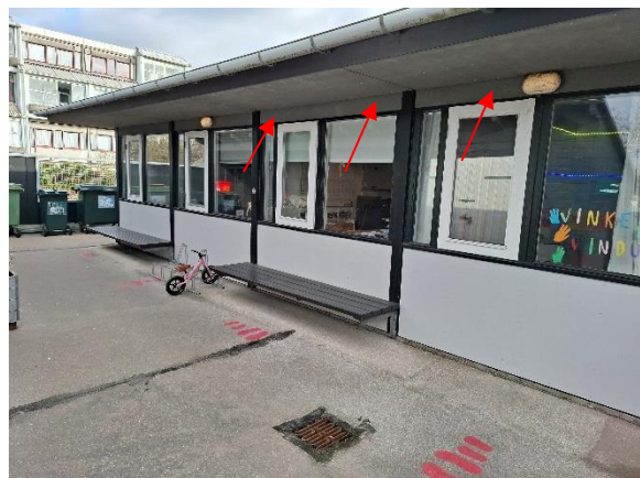
Uisolerede fyldninger over vinduer
