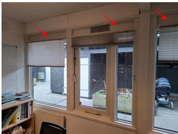
Uisolerede fyldninger over vinduer
