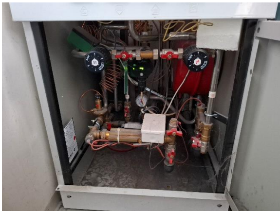
Varmeveksler placeret bagerst i unit
