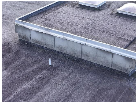
Fibercementplader og alu sternkapsler
