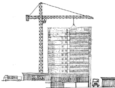
Nedrivning ved kran – store stykker beton løftes ned og køres væk.
