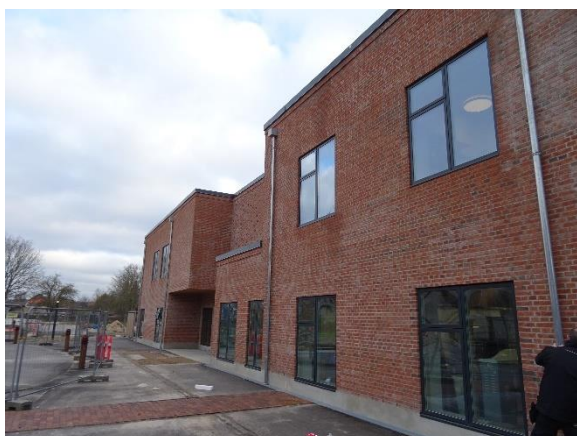
Nye vinduer i træ/alu, 3-lags energiruder med varm kant
