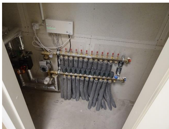
Gulvvarmeanlæg med Wavin styring
