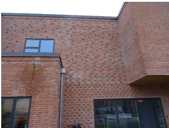
Murværk med slør
