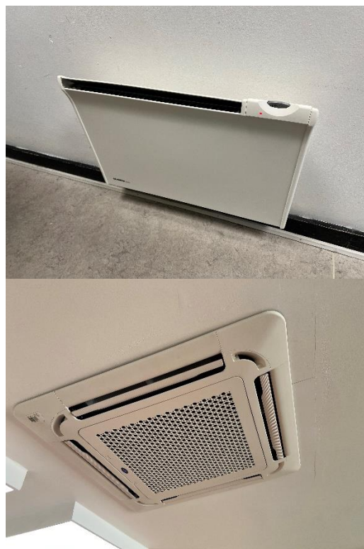
Varmepumpe fancoil + El radiator
