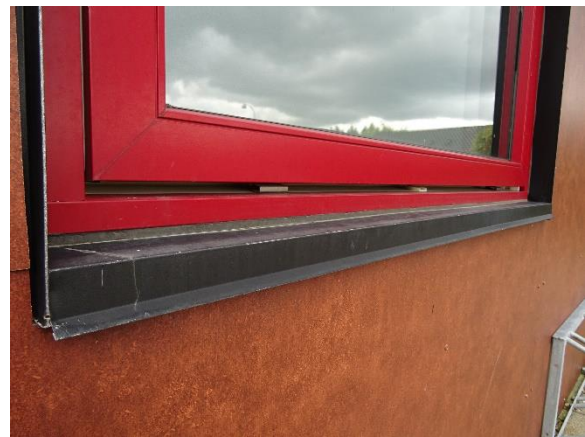
Oprindeligt vindue med nedbrydning i ramme.
