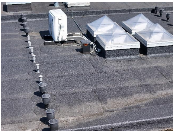
Nye ovenlys og udluftningshætter på tagflade.
