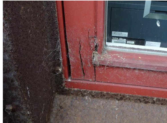
Oprindeligt vindue med nedbrydning i ramme.
