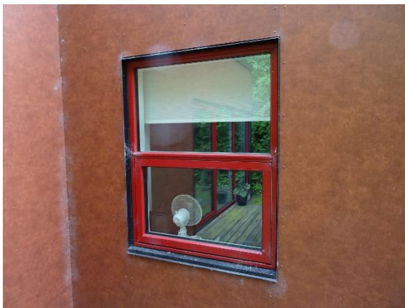
Træ/alu-vindue i tilbygning fra 2001
