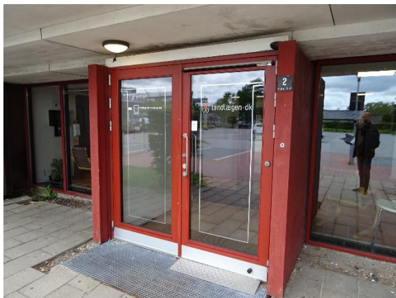
Hovedindgangsdør i træ med automatik
