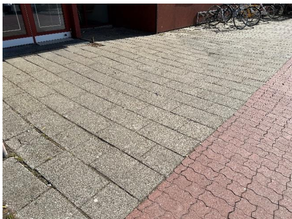
Belægnings sten foran indgangen
