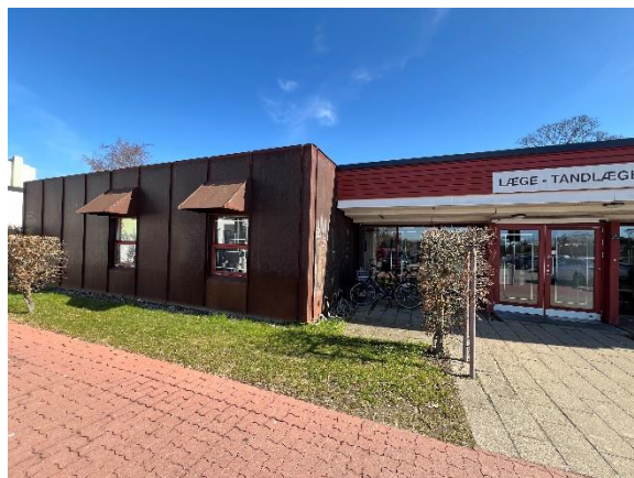
Facade med vinduer og glasparti.
