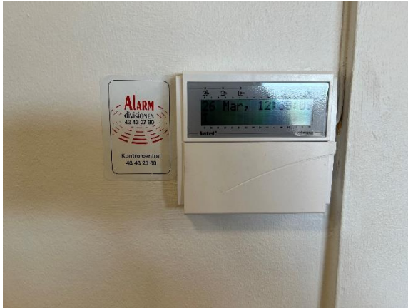
Indbrudsalarm, AIA, hovedpanel
