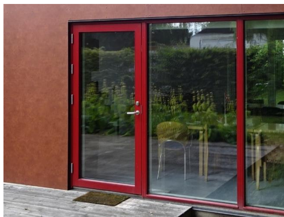
Træ/aluminium-dør til frokoststue i tilbygning
