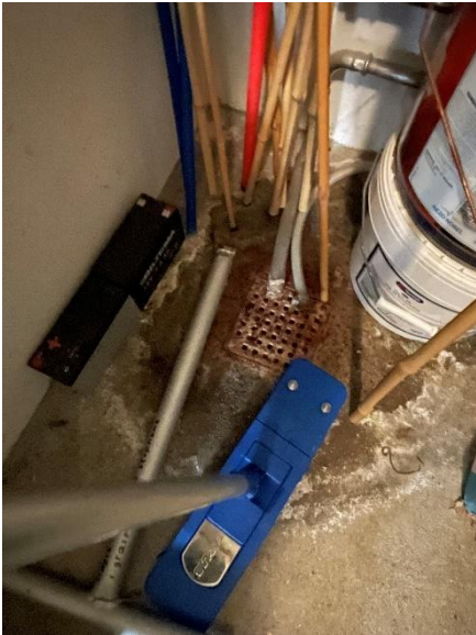
Afløb i teknikrum bygn.18
