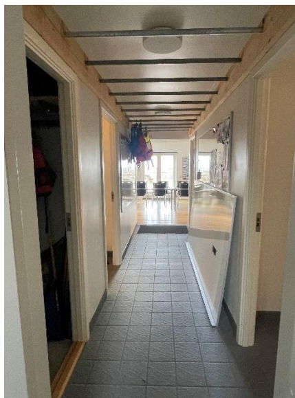
Flisegulv i mellemgang bygn. 18
