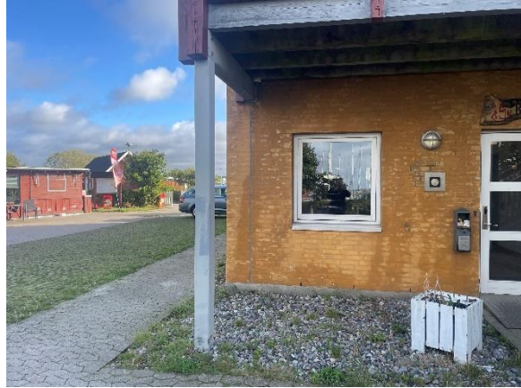
Belægningen rundt om bygn. 20
