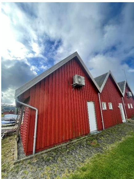
Facadegavl på bygn.18
