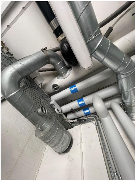
Vandinstallation i bygn.20
