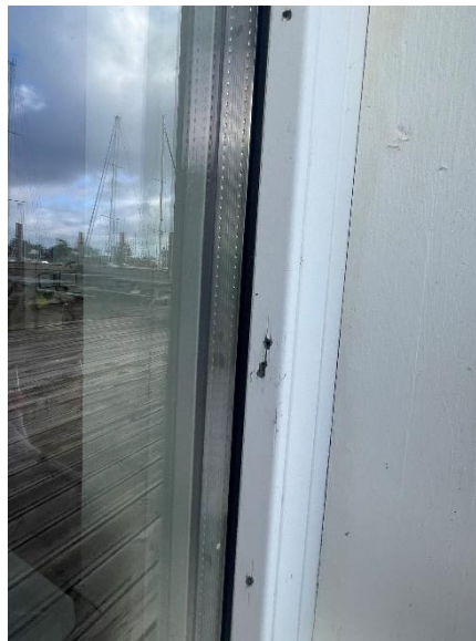
2 lags energirude med koldkant bygn. 18
