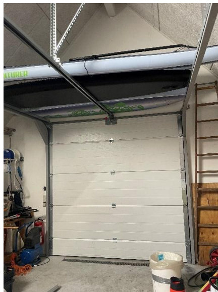
Port til bygn. 18 set indvendigt
