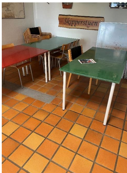
Flisegulv i sejlkлуб fælleslokale, i stueetagen bygn 18.
