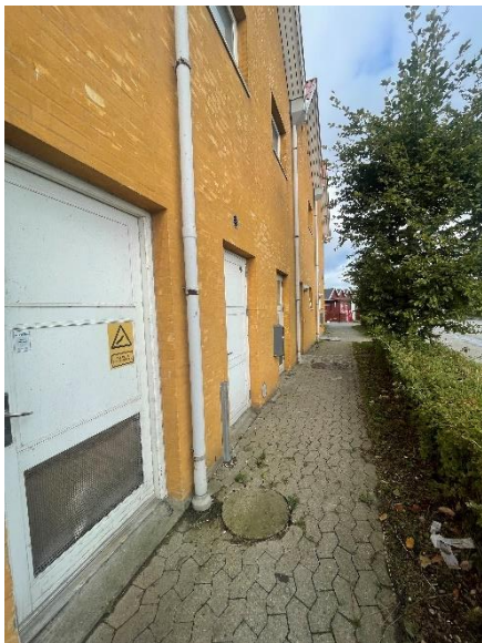
Massive døre til teknikum og vaskerum
