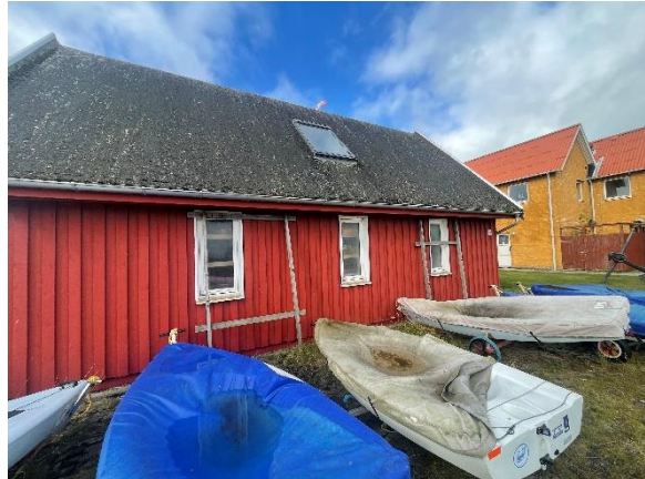
Bygning 18 udført med tagpap
