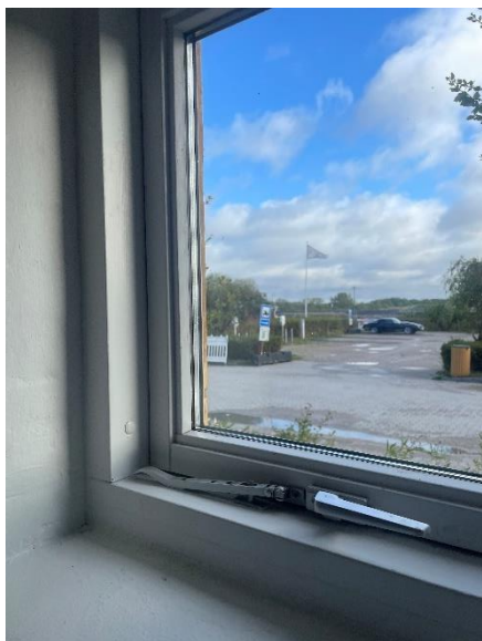
Vindue i stueetagen bygn.20
