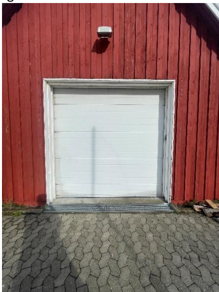
Port til bygn. 18 set udvendigt
