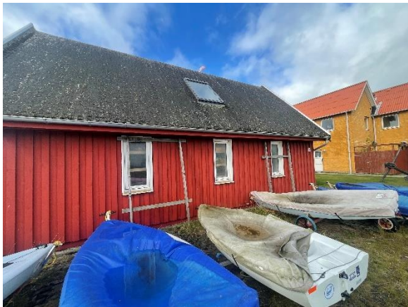
Vinduer i facade på bygn. 18
