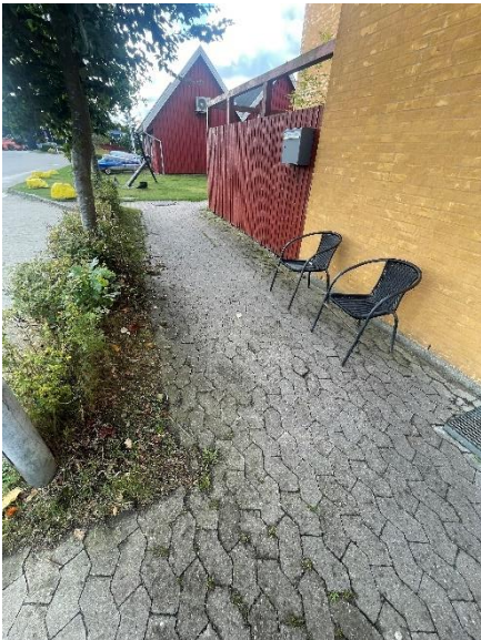
Belægningen rundt om bygn. 20
