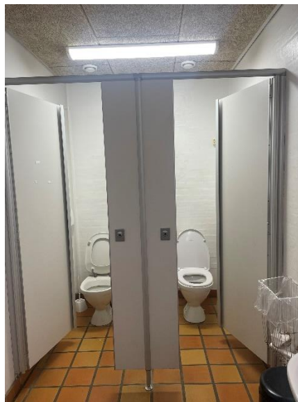
LED armatur bygn.20
