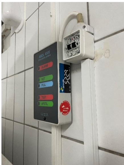
ADK dørpanel mellem køkken og restaurant bygn.20
