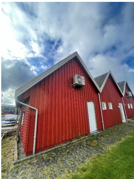
Facaden med 1 på 2 brædder bygn.18
