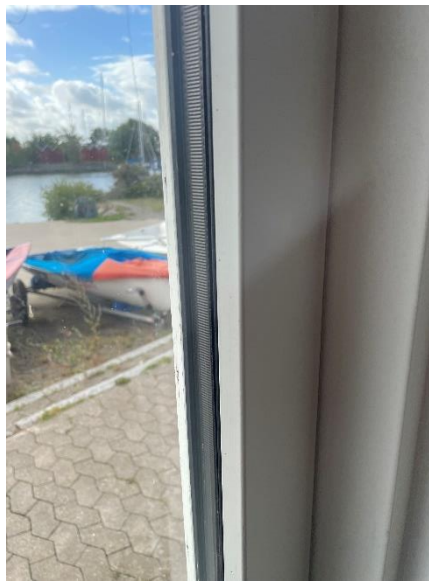
2 lags energirude med varm kant bygn. 18
