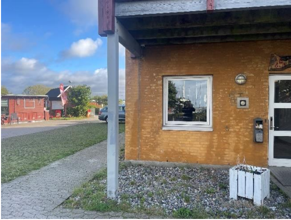
Facadeende set på bygn.20
