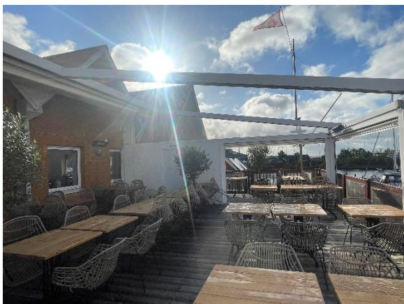
Solsejl over del af terrasse ved restauranten 1.sal bygn.20
