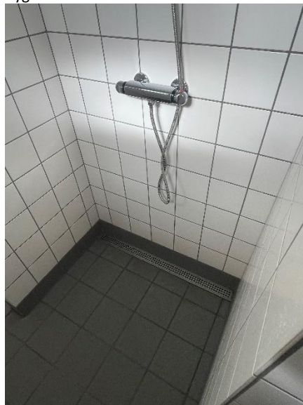
Afløb for brusekabine i bygn.18
