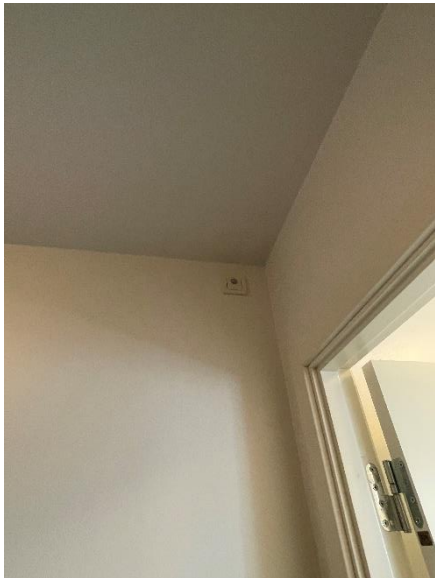
Gipsvægge og loftkonstruktion i mellemgang i bygn. 18
