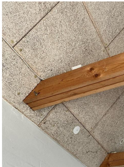
Troldeksloft og spær konstruktion på 1.sal i bygn. 20
