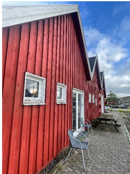
Facadegavl på bygn.18
