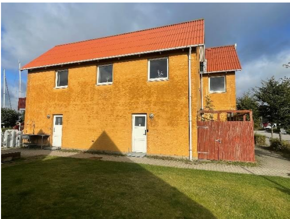
Endefacade på bygn.20 med indhegnet gårdhave på højreside
