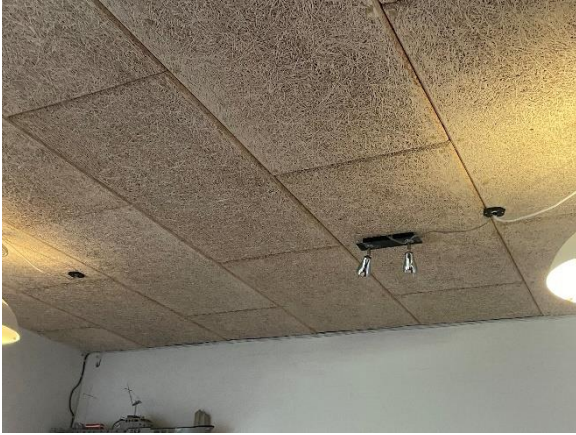
Troldeks loft i bygn. 20
