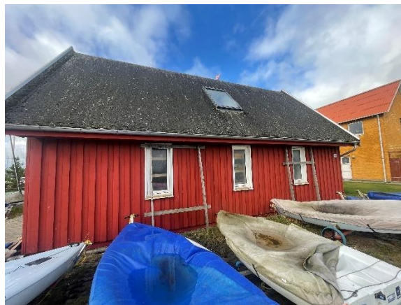
Facade bygn.18 væk fra havnen.
