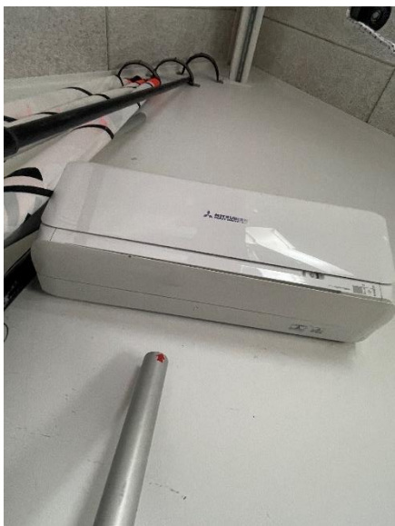
Mitsubishi varmepumpe inder del luft-luft bygning.18
