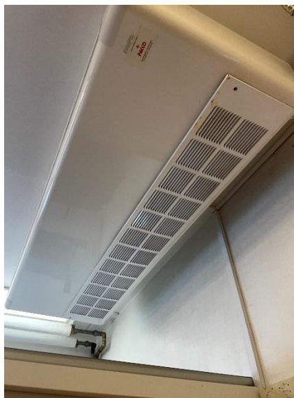
Varmepumpe inder installation i bygning.20
