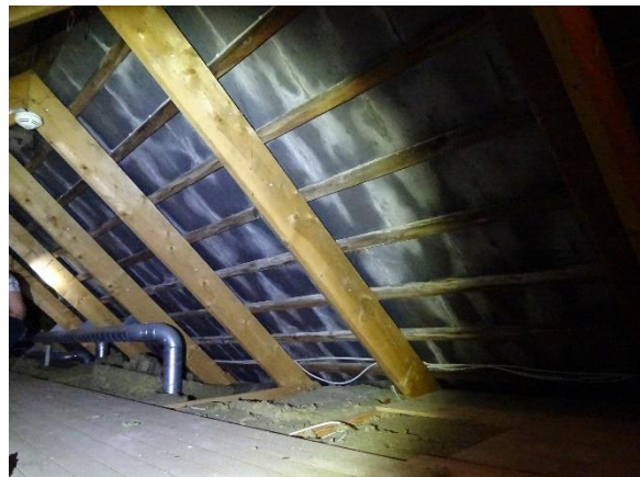
Loftsrum med oprettede spær
