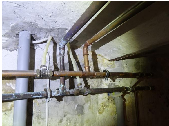
Afgreninger i kælder
