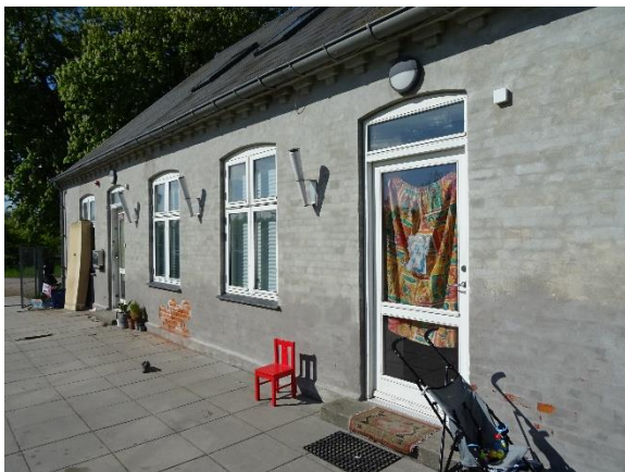
Indgangsdøre mod øst
