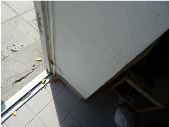
Facade indvendigt isoleret
