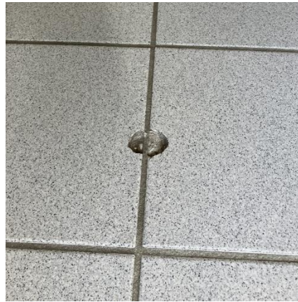
Klinker slået i stykker – Entré stue-etage
