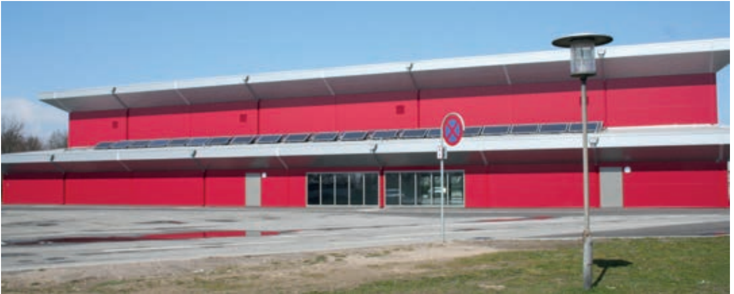
Solceller på Stadionhal 1
